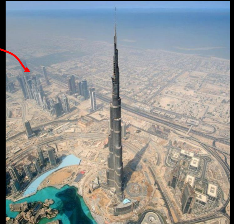
Burj Khalifa, (mestadels i) armerad betong , världens högsta byggnad (828 m) då den invigdes år 2010
