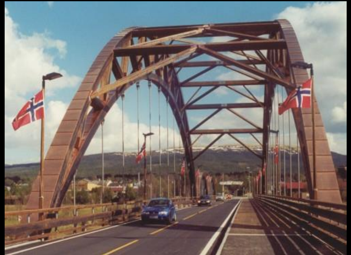
Tynsetbro, Norge, spännvidd 71 m
