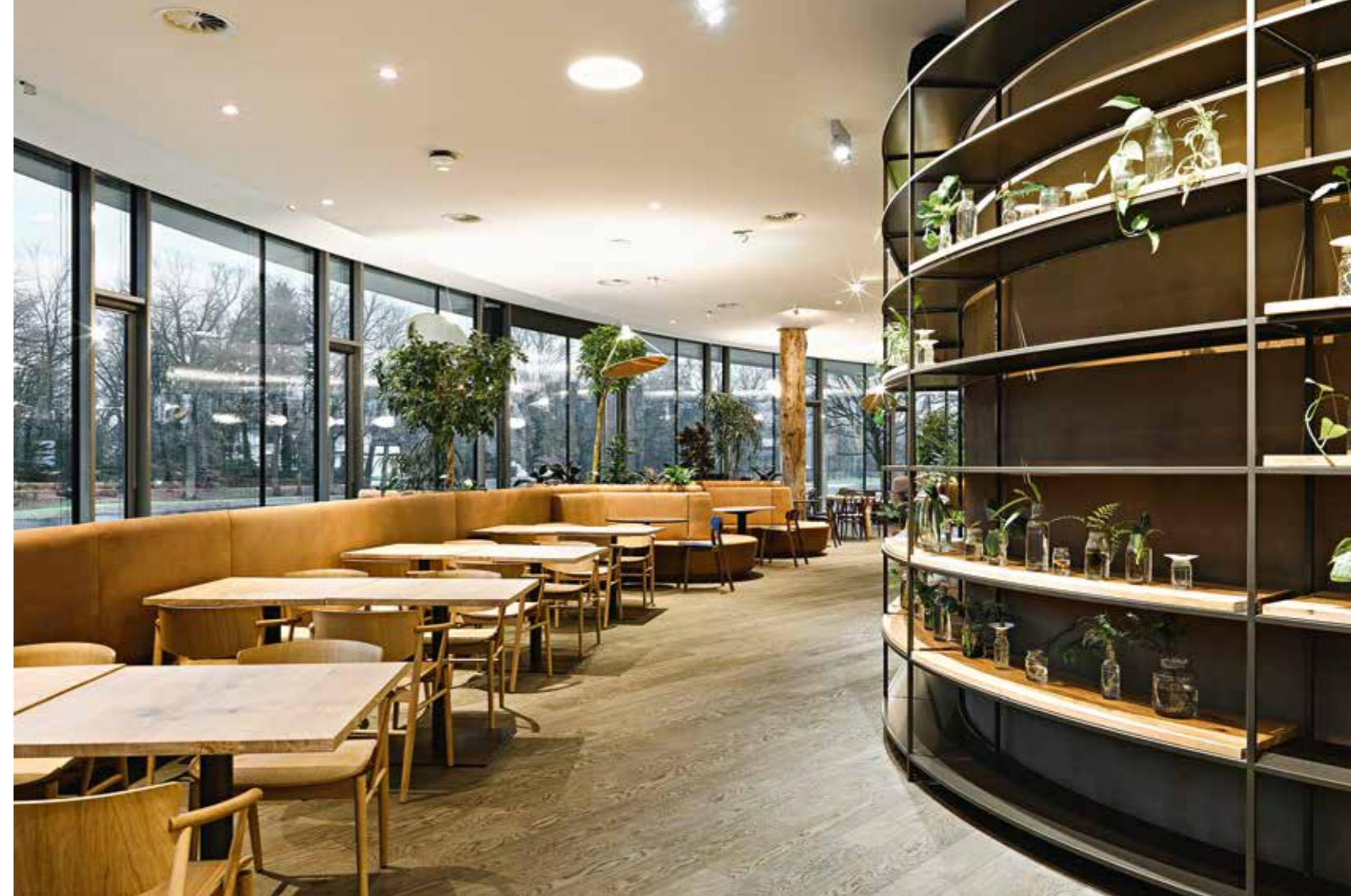
Byggnaden innehåller redan återanvänt material, som takbjälkar samt golvet i restaurangen. Trädstammarna går genom hela byggnaden, de har både en visuell och bärande roll.
