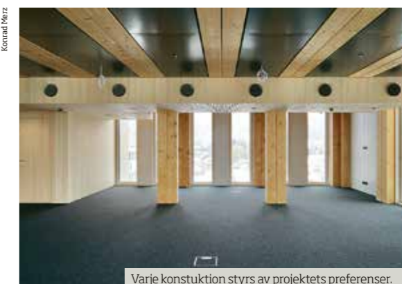
Varje konstruktion styrs av projektets preferenser. Konrad Merz kombinerar gärna limträ med betong och prefabricerar när det är möjligt.
