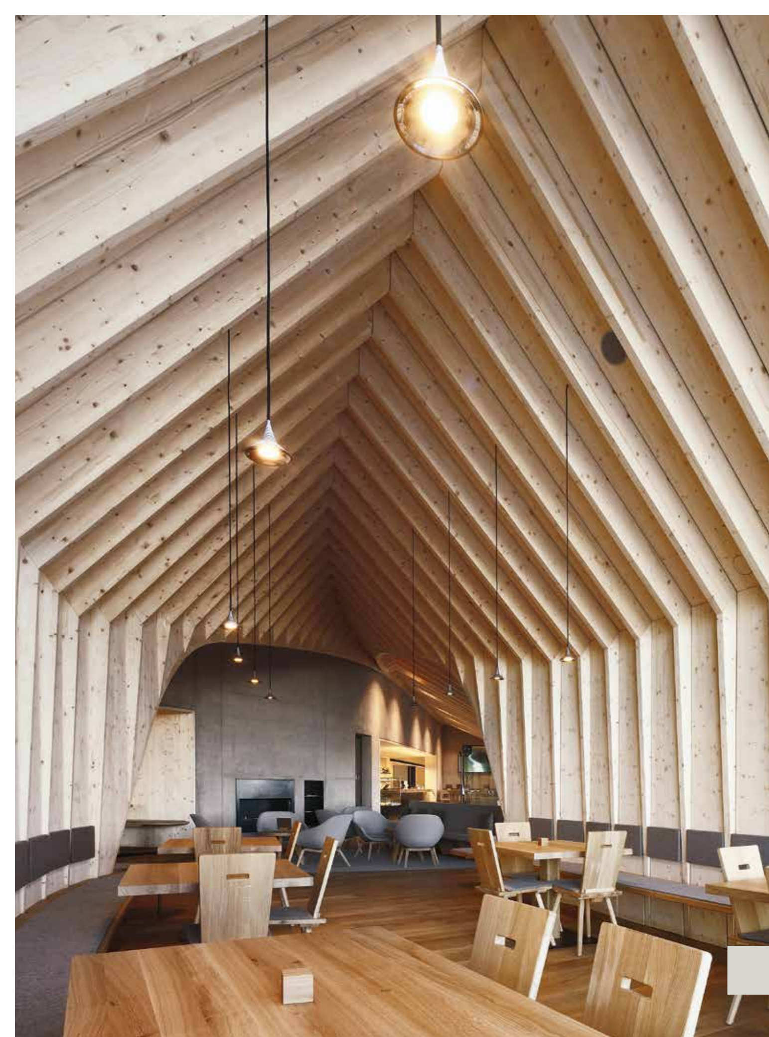
Den synliga träkonstruktionen, med rammar av limträ, visar byggnadens struktur och ger rummet en öppen och ståtlig känsla.
