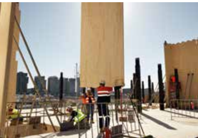
Montage av KL-träskivor till väggar.
