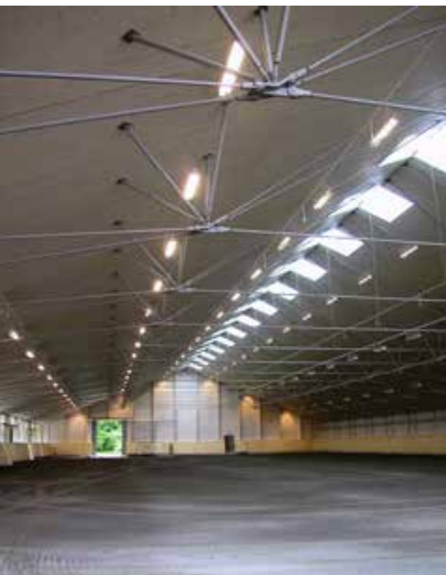
Underspänd takplatta av KL-trä, Flyinge Ridskola, Lund.
