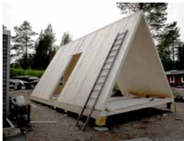
Montage av sommarhus, Skellefteå.
