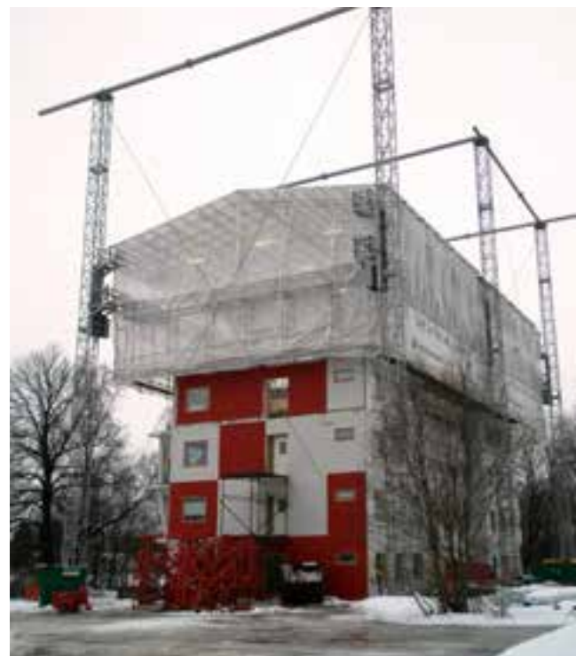
Exempel på klättrande väderskydd för torrt byggande vid hög prefabriceringsgrad, Älvsbacka Strand, Skellefteå.
