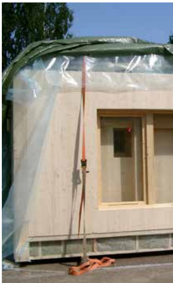
Prefabricerade väggelement på väg att avtäckas i samband med montage.
