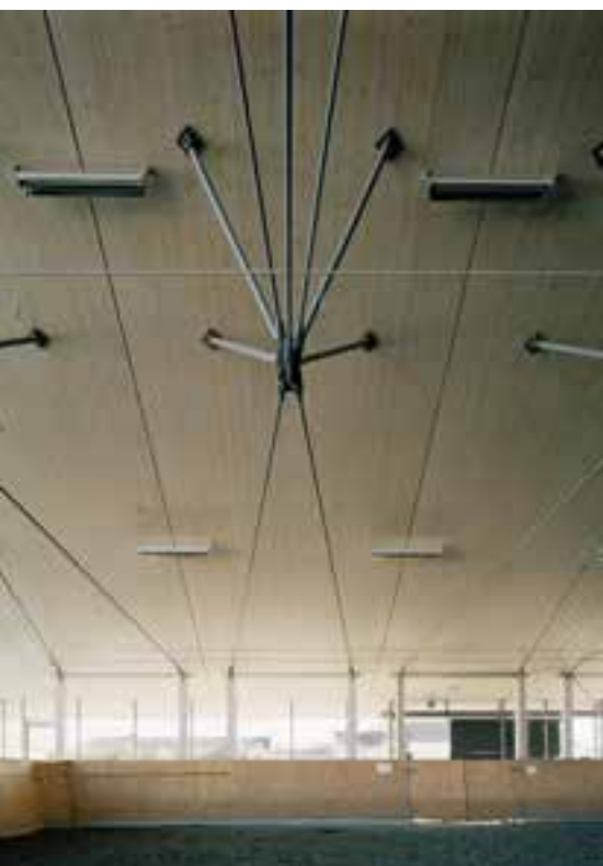
Underspänd takplatta av KL-trä, Flyinge Ridhus, Lund.
