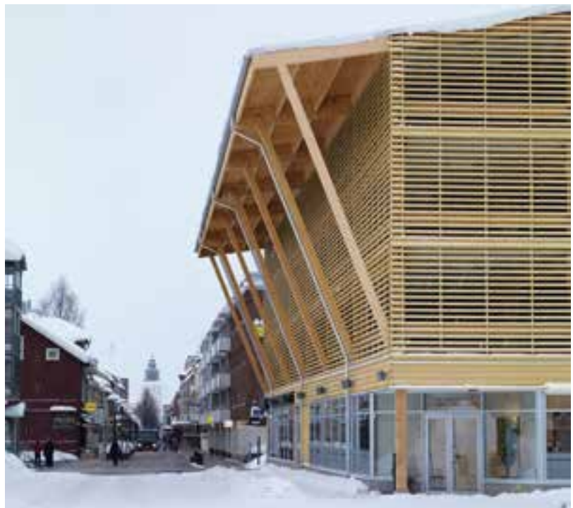
Parkeringshus med bärande bjälklag av KL-trä, Skellefteå.
