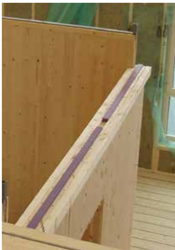
Exempel på vibrationsdämpande mellanlägg.
