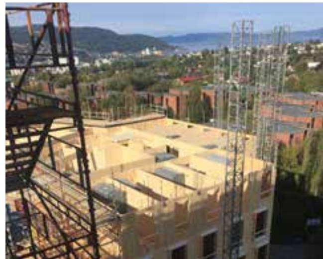
Exempel på byggande utan väderskydd, Moholt 50|50, Trondheim.
