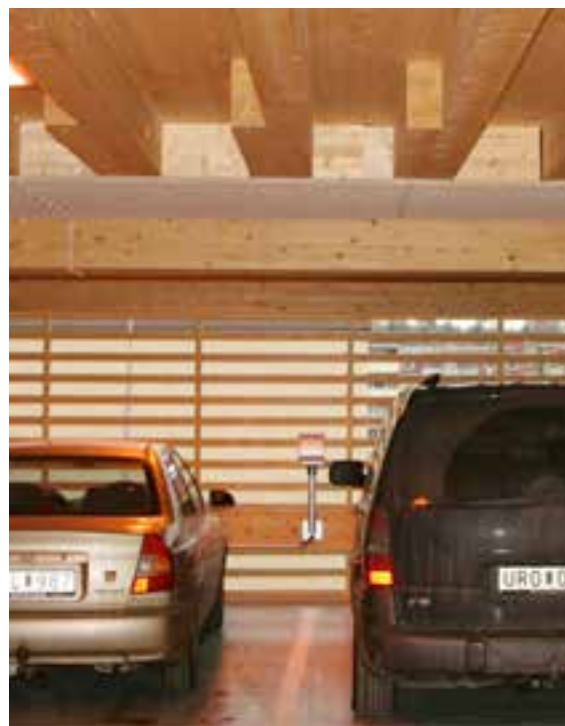
KL-träplatta i samverkan med limträbalkar. Bjälklag i parkeringshus, Skellefteå.
