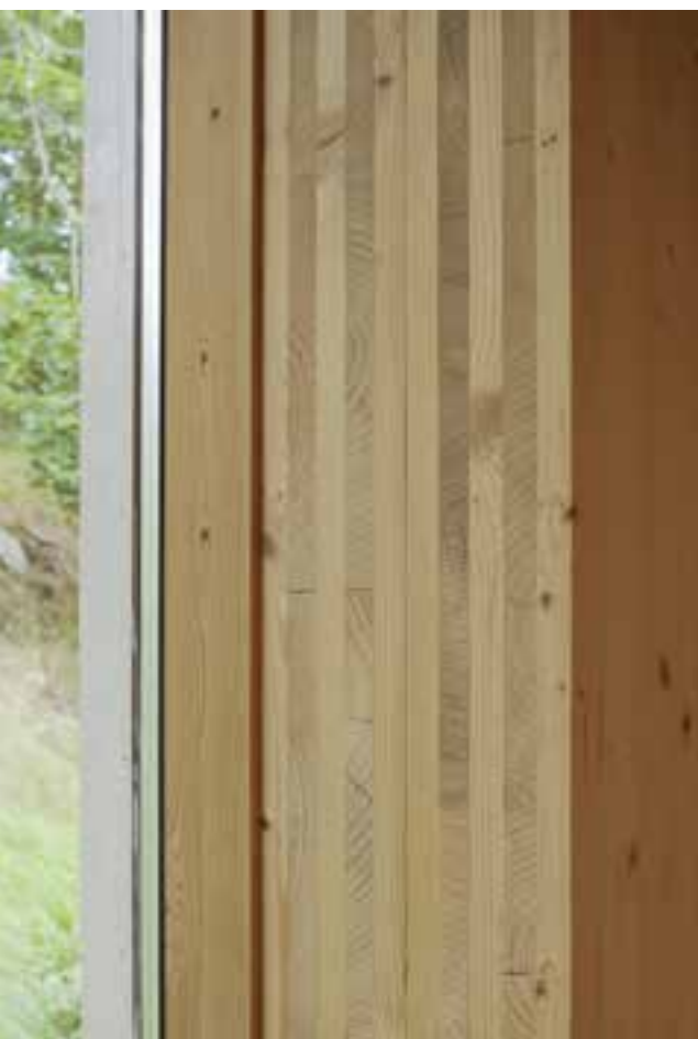
Yttervägg av KL-trä.
