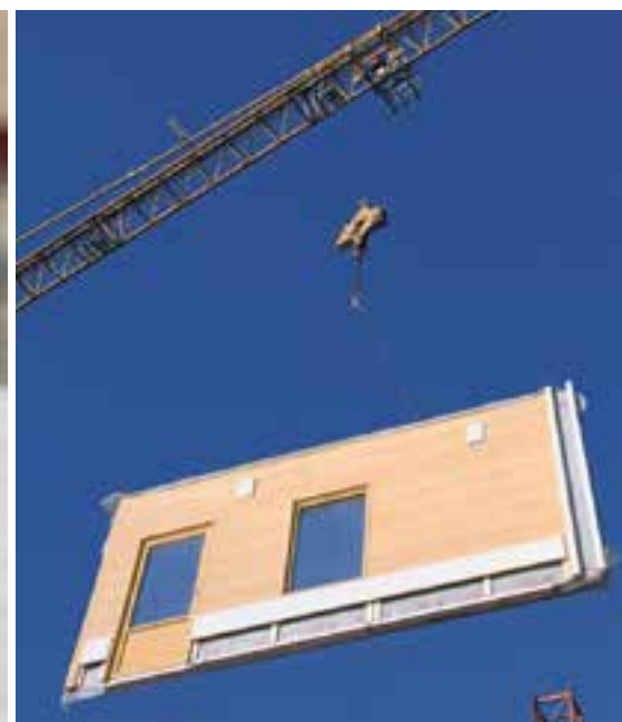
Lyft av prefabricerat väggelement.
