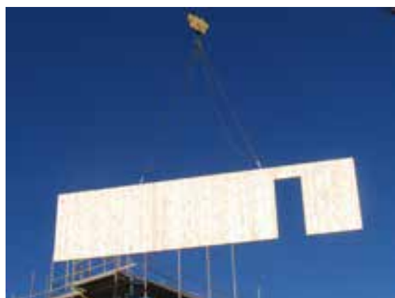
KL-träskiva fungerande som en sammanhållande balk ovan dörröppning, Hyttkammaren, Falun.
