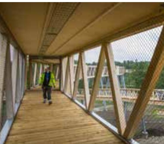
Fackverksbro av limträ med takplattor av KL-trä, djurpark, Borås.
