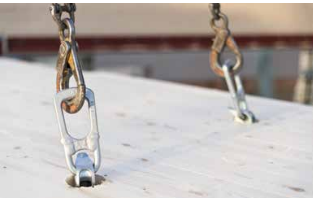
Kulankare för infästning med träskruvar.
