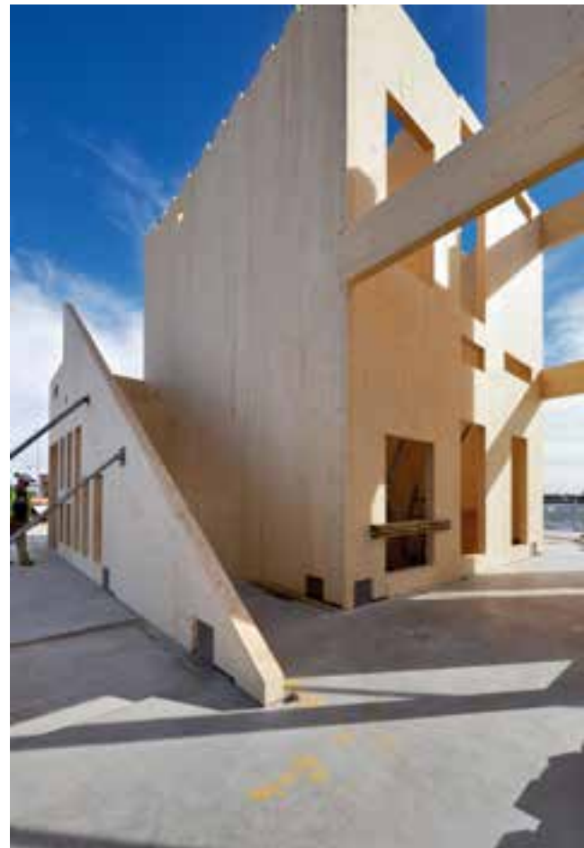
Montage av väggskivor av KL-trä.
