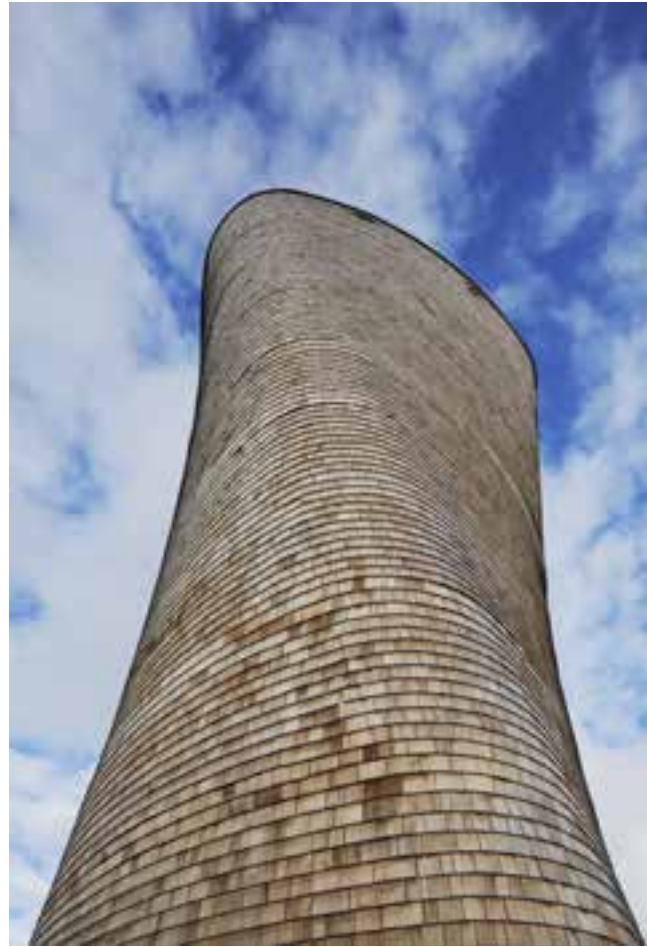
Ventilationstorn med KL-trästimme, Stockholm.
