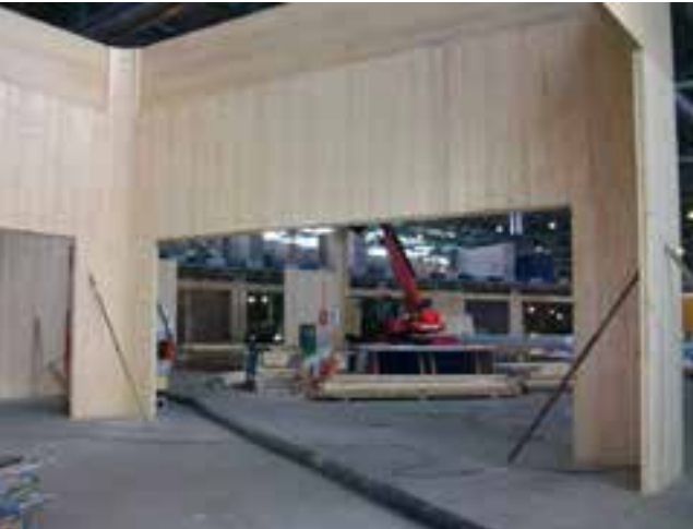
KL-träväggar under uppförande, Bromma Blocks, Stockholm.
