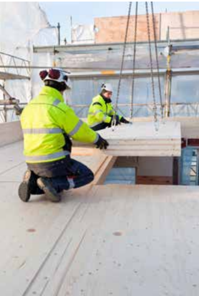
Montage av KL-trä.
