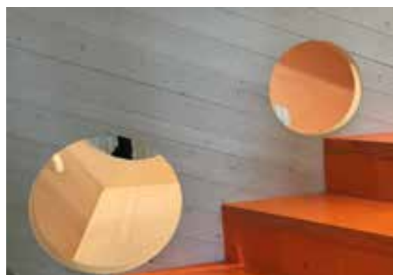
Exempel på håltagning i KL-trä. Skivornas uppbyggnad gör att det finns stora möjligheter för arkitektonisk utformning och anpassning mot beställarens önskemål och krav.
