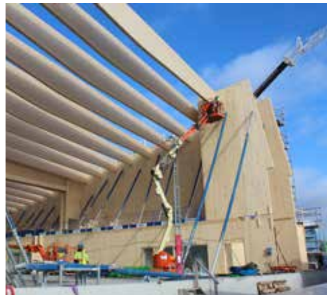
Stabilisering med hjälp av stag under byggtiden.
