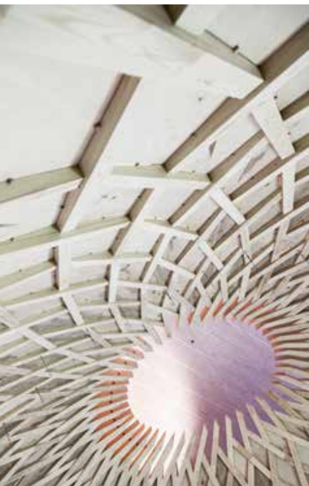
Takkonstruktion med limträ och KL-trä.
