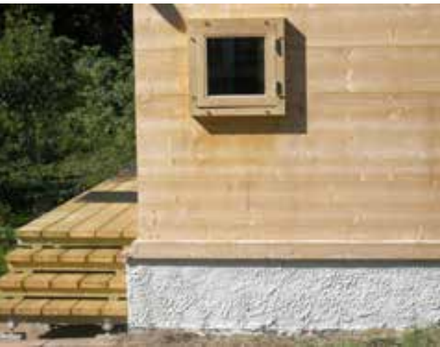
Sommarhus under uppförande, Öland.
