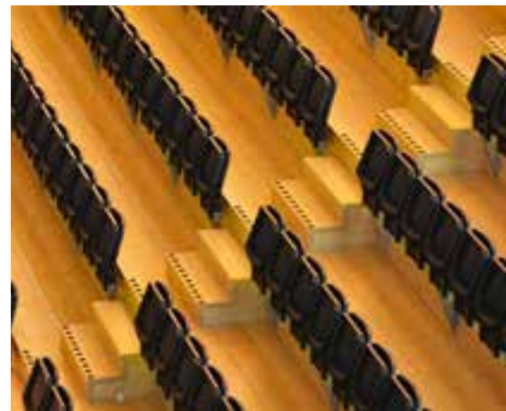
Läktare av KL-trä, Uppsala.
