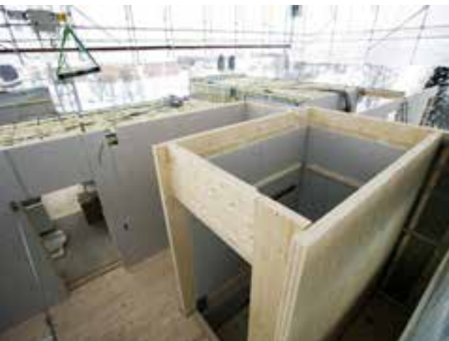
Hisschakt av KL-trä.
