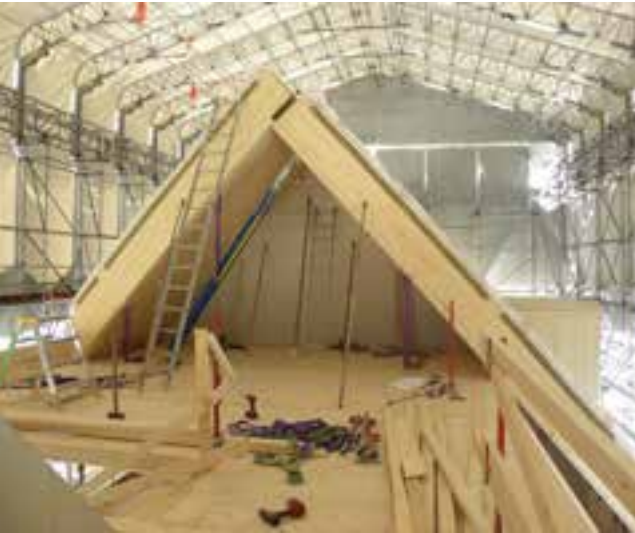
Montage av takkonstruktion, Sundbyberg.
