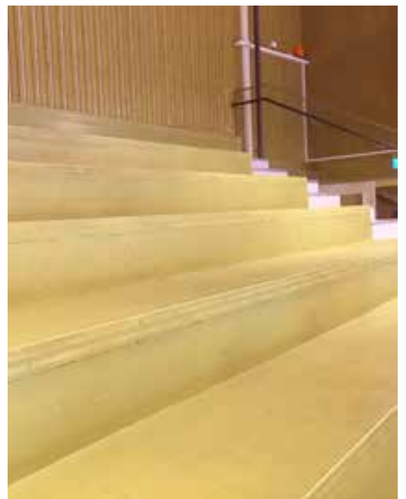
Gradängar av KL-trä i idrottshall, Järfälla.
