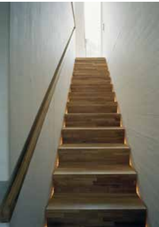
Trappa med handledare urfräst ur KL-träskivan som bildar väggen.
