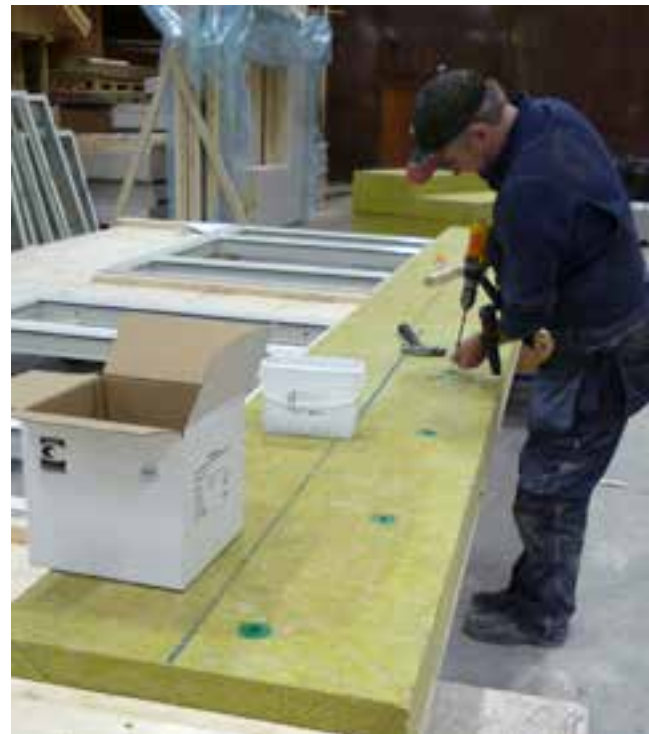
Isolering av väggelement av KL-trä.
