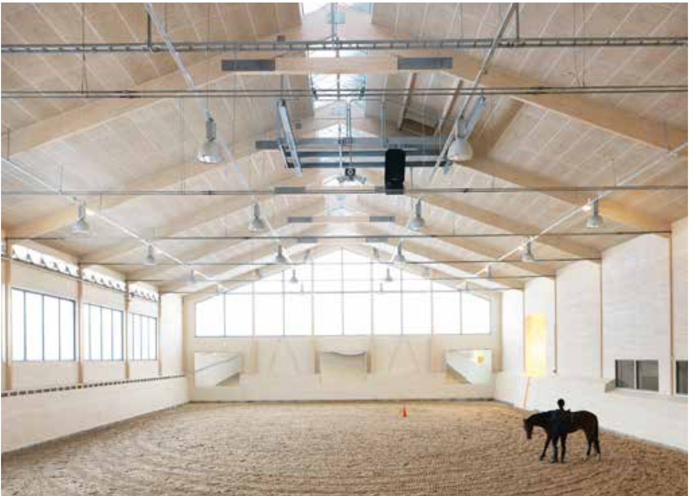
Ridhus med väggar och sarger av KL-trä, Sättra.
