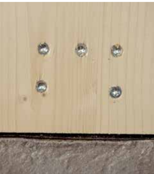
Skruvförband i KL-träskiva.
