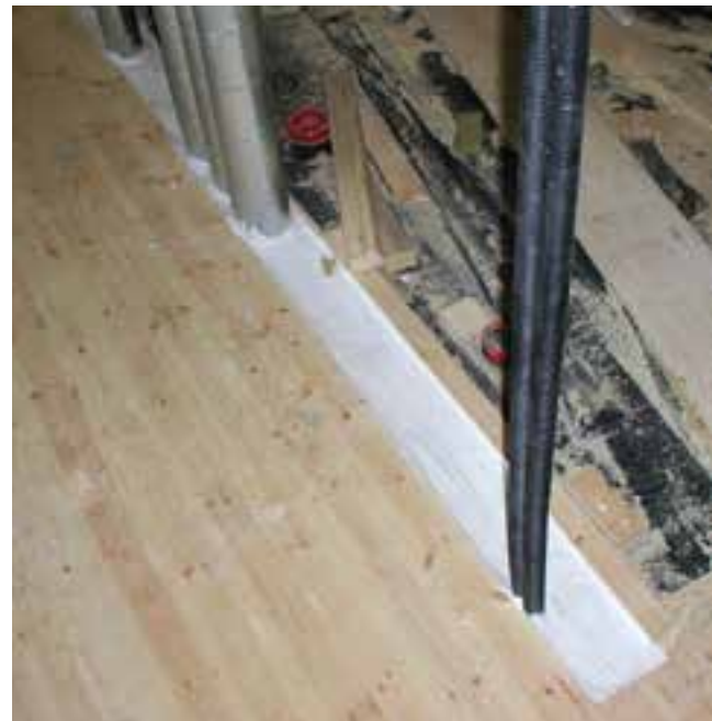
Exempel på tätad genomföring i ett KL-träbjälklag.
