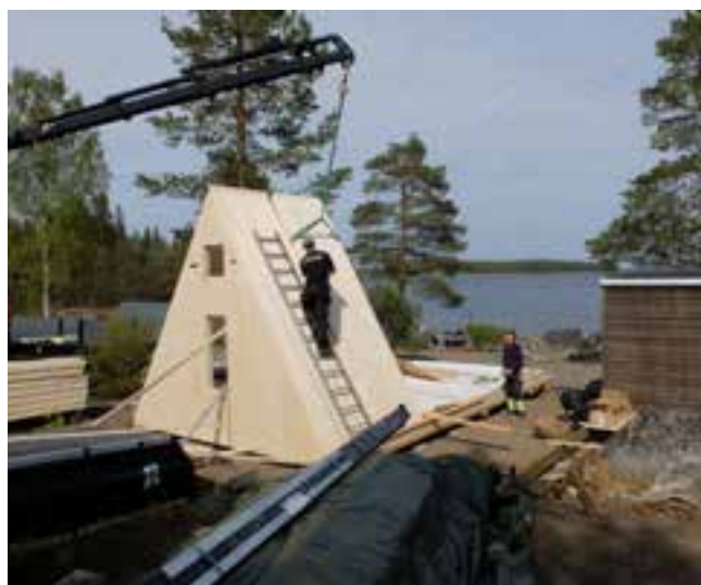
Montage av sommarhus, Skellefteå.
