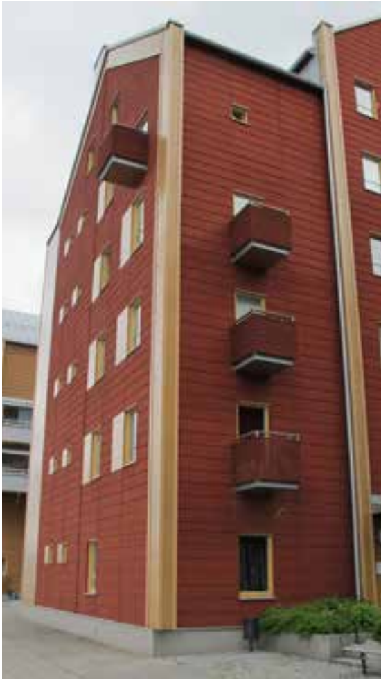
Balkongplattor av KL-trä, Inre Hamnen, Sundsvall.
