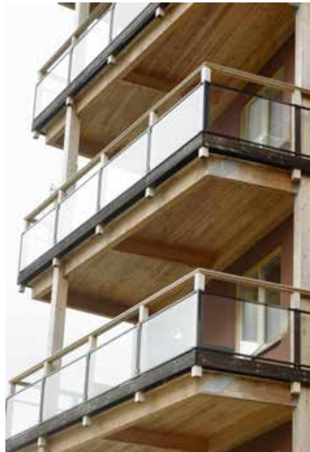
Balkonger av KL-trä, Växjö.
