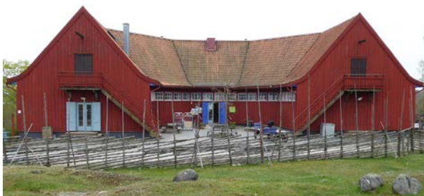
Hästkostallet från 1930 vid Ulriksdals travbana i Solna (arkitekt Cyrillus Johansson) fick det första bjälklaget i massivträ, när det flyttats till Överjärva gård 1995. FOTO: HOLGER ELLGAARD
