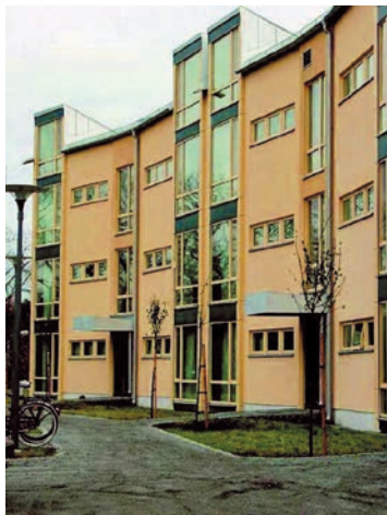
Gästforskarbostäder nära KTH var 2000 det första moderna trähuset med mer än två våningar i Stockholm. Arkitekt Bengt Hidemark.
