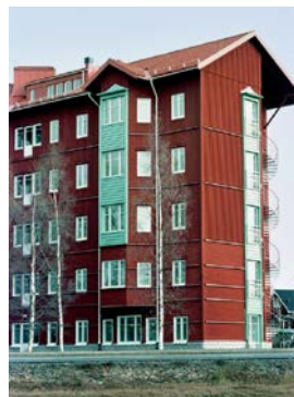
Kontorshuset Lotsen i Skelleftehamn 1998 kunde förses med träfasad eftersom fönstren var låsta, vilket inte är lämpligt i bostäder.
