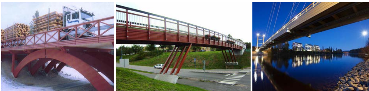
Exempel på moderna träbroar, från vänster vägbro för tung trafik, Klockarbergsvägen i Skellefteå 1994, i mitten gång- och cykelbro i Skövde och till höger vägbro över Skellefteälven i Skellefteå 2011. Martin Gustafsson var starkt engagerad i utvecklingen av träbroar från början av 1990-talet, senare även Anna Pousette och Anders Gustafsson.
