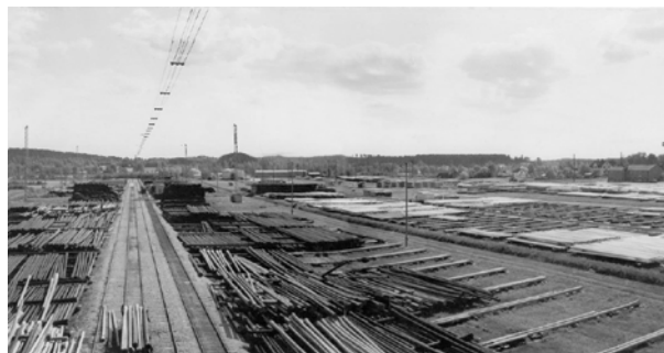
Vattenfalls impregneringsanläggning i Åsbro strax söder om Hallsberg vid mitten av 1950-talet.
