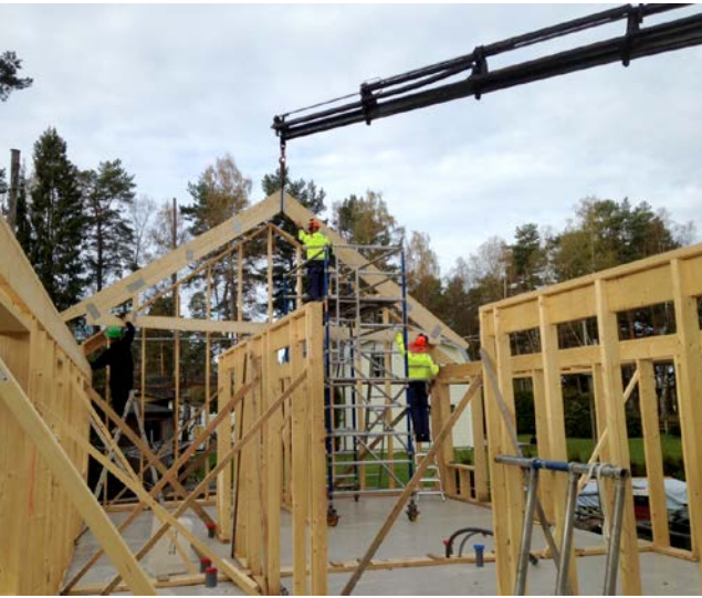
Montage av takstol från ställning.
