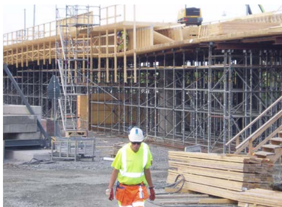
Fackverkskonstruktion vid brobyggande.
