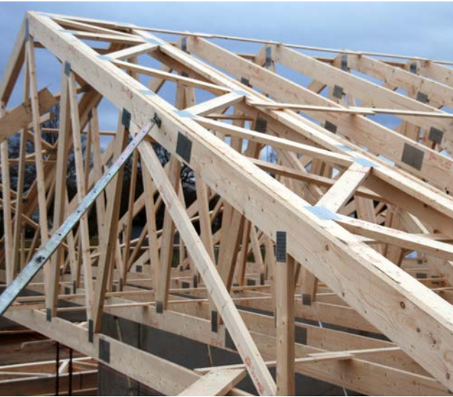
Stabiliserande system med parallellfackverk.
