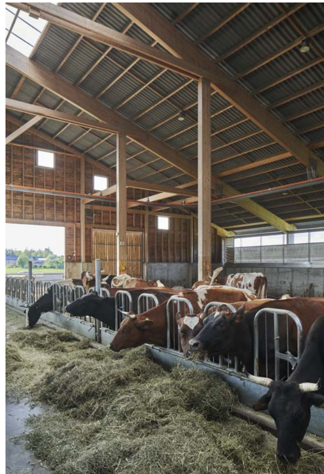
Kostall med takstolar av limträ.
