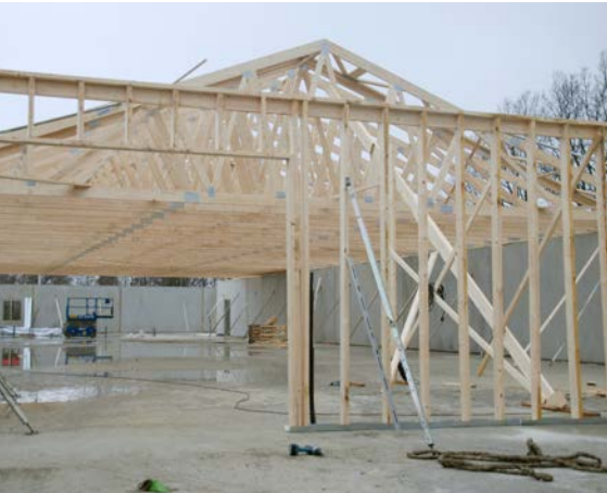
Pågående bygge med fackverkstakstol.
