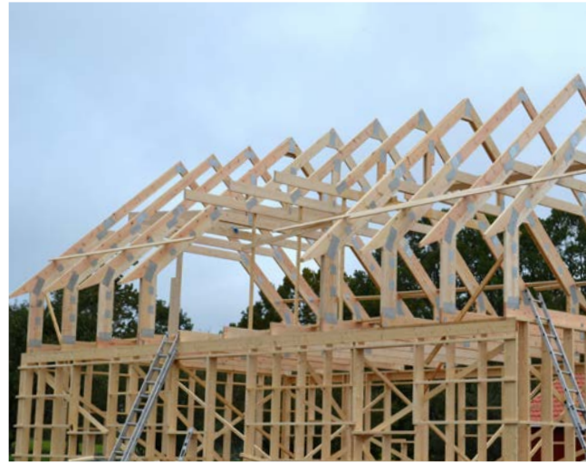
Pågående bygge av småhus med ramverkstakstolar.
