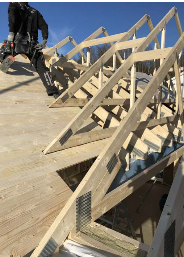
Sammanbyggnadstakstol för anslutning mot tak.
