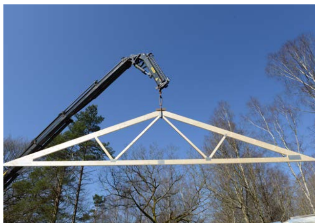
Lyft av fackverkstakstol.
