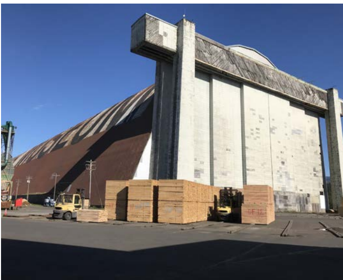
Hangar för zeppelinare byggd på 1940-talet. Takkonstruktionen av träfackverk.
