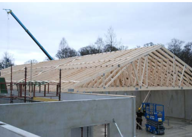
Pågående bygge av medelstor byggnad med parallellfackverk.
