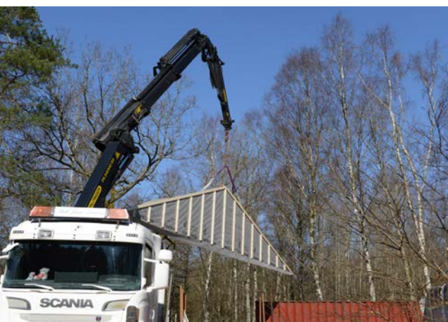
Avlastning av gavelspets från lastbil.
