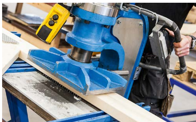
Tillverkning av takstol.
