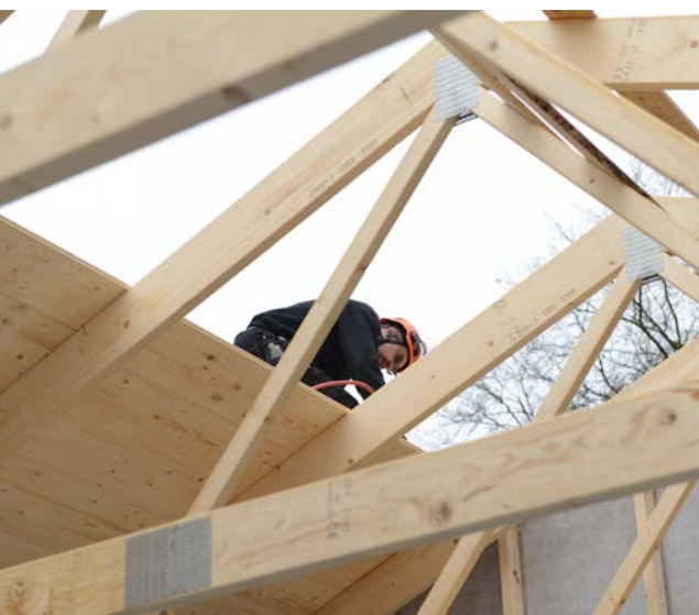
Montering av underlagsspont.
