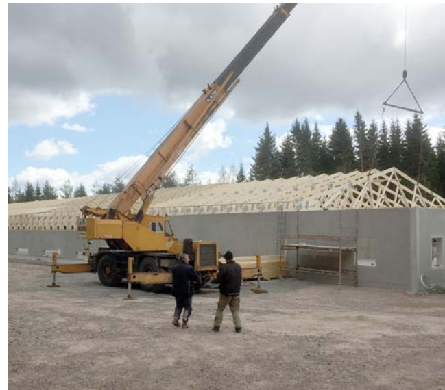
Montage med mobilkran och lyftok.
