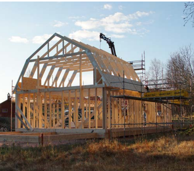
Pågående montage av ramverkstakstol, så kallad mansardtakstol.
