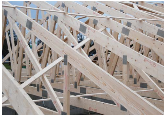
Knäckavstyvning av diagonaler i fackverkstakstol.
