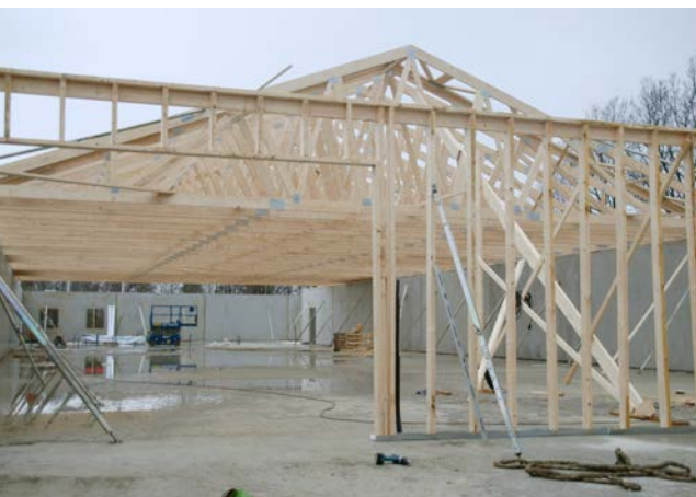
Pågående byggprojekt med fackverkstakstolar.
