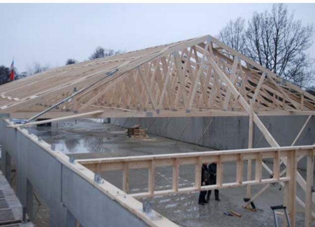
Tillfällig stabilisering av takkonstruktion.
