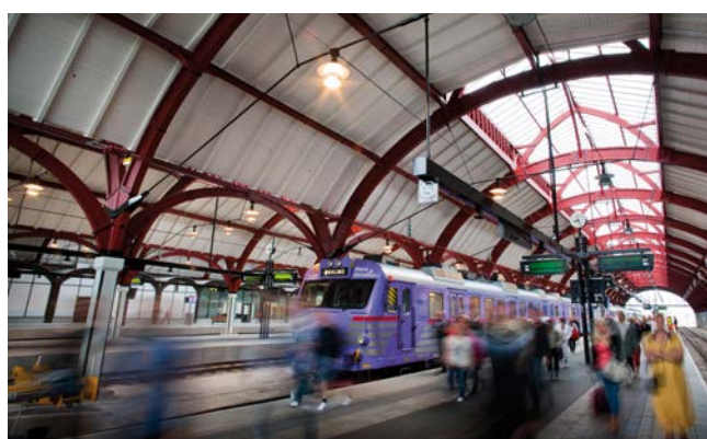
Malmö Centralstation. Banhall byggd 1923. En av de första stora leveranserna av limträ i Sverige. Banhallen är i bruk än idag.
