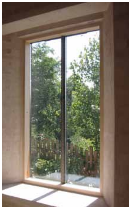
Finestre-fönstret har utvecklats av Pål Dunér tillsammans med Henrik Malmros och Fredrik Langéén, för att ha största möjliga ljusinsläpp och mycket hög detaljutformning utan att göra avkall på energieffektivitet.
