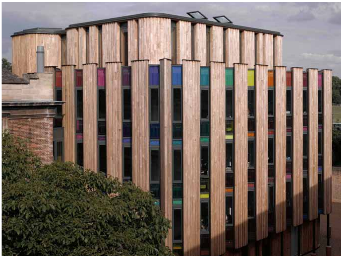
De 9 meter långa träribborna är uppbyggda av 10 centimeter breda och 22 millimeter tjocka plankbitar som fingerskarvats och limmats ihop med motsatta fiberriktningar för att motverka deformationer. Träet är obehandlat för att ge en gråtonad karaktär och minimera fasadunderhållet.
