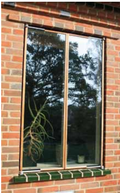
Finestre-fönstret har utvecklats av Pål Dunér tillsammans med Henrik Malmros och Fredrik Langéén, för att ha största möjliga ljusinsläpp och mycket hög detaljutformning utan att göra avkall på energieffektivitet.
