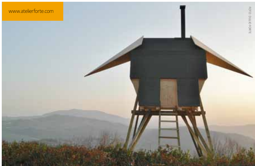
Huginn & Muninn är gjord helt i granvirke, med underdelen i impregnerat virke. Beställarna bestämmer själv om bastun ska målas eller inte.
