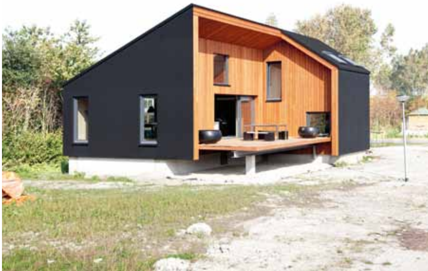
En EPDM-gummiduk täcker fasad och tak.
