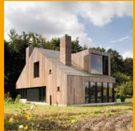
Skorstenen är den bärande idén i Onix tillbyggnad av en villa i Bosschenhoofd. Betonggjutningens träform används till fasadtäckning, tak och innerväggar.
