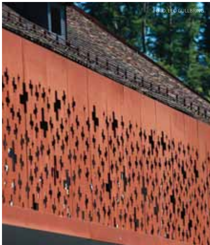
Leuppi & Schafroth Architekten AG:s nya besökscentrum klär in en gammal träbyggnad i cortenstål.
