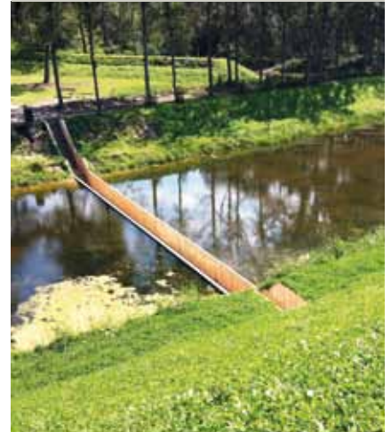
Den schaktlika vattenpassagen är utförd helt i accoya-trä som är både FSC- och PEFC-certifierat. En EPDM-gummiduk håller brokonstruktionen vattentät.
