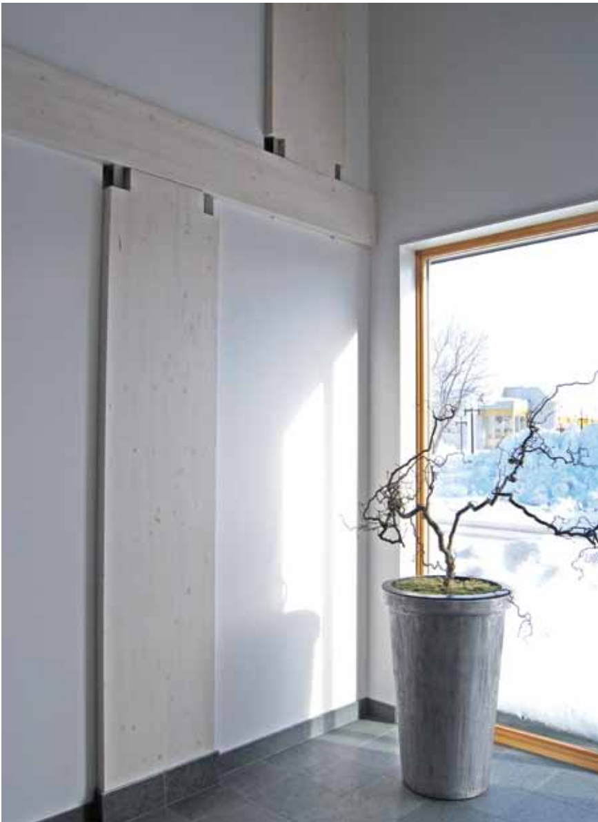
Kårhuset vid Campus Skellefteå är ett exempel på japansk konstruktionsteknik i Sverige. Kårhuset är byggt med det japanska trästomsystemet "Big Frame" som professor Hideyuki Nasu varit med och utvecklat tillsammans med SP Träteknik.
