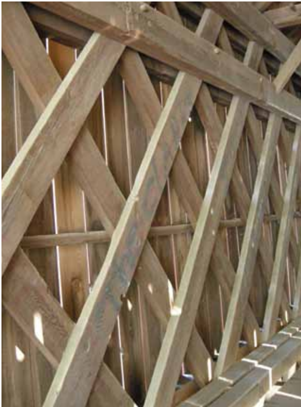
Knecht's Covered Bridge är en av tolv täckta träbroar i Bucks County, Pennsylvania, och ligger inbäddad i lövskogen vid vattendraget Durham Creek nära Springfield. Knecht byggdes 1873 och använder hängverket Town lattice truss, en patenterad konstruktion av Ithel Town från år 1820.
