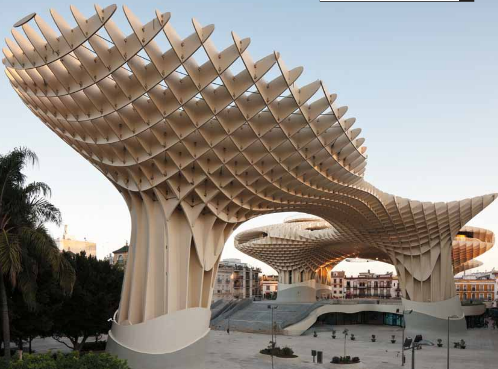
Uppmot 3 400 Finnforest Kerto LVL-element har anpassats med hjälp av CNC-fräsning. De 35 000 hålen för de inlimmade ståltagen har däremot borrats för hand.
