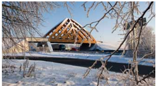
Bron är utförd i accoya-trä som produceras i Arnhem, ett acetylerat trämaterial som ska klara uteklimatet utan problem och ge en lika lång livslängd som betongbroar.
