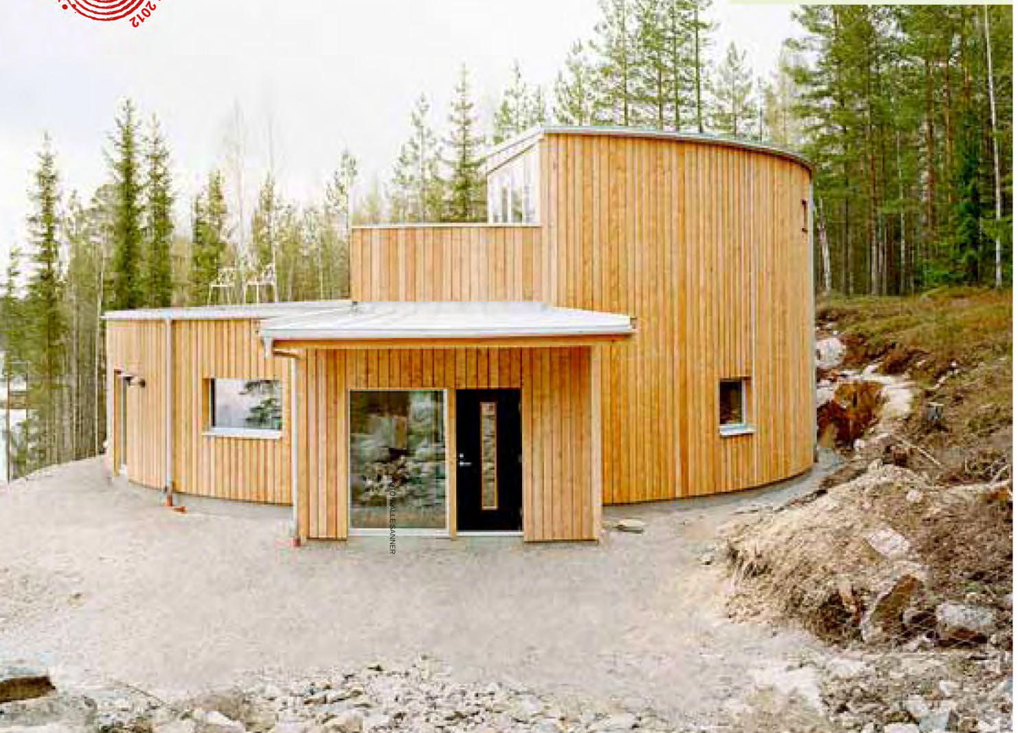
Värmebehandlad furupanel klär typhusets svängda fasad.
