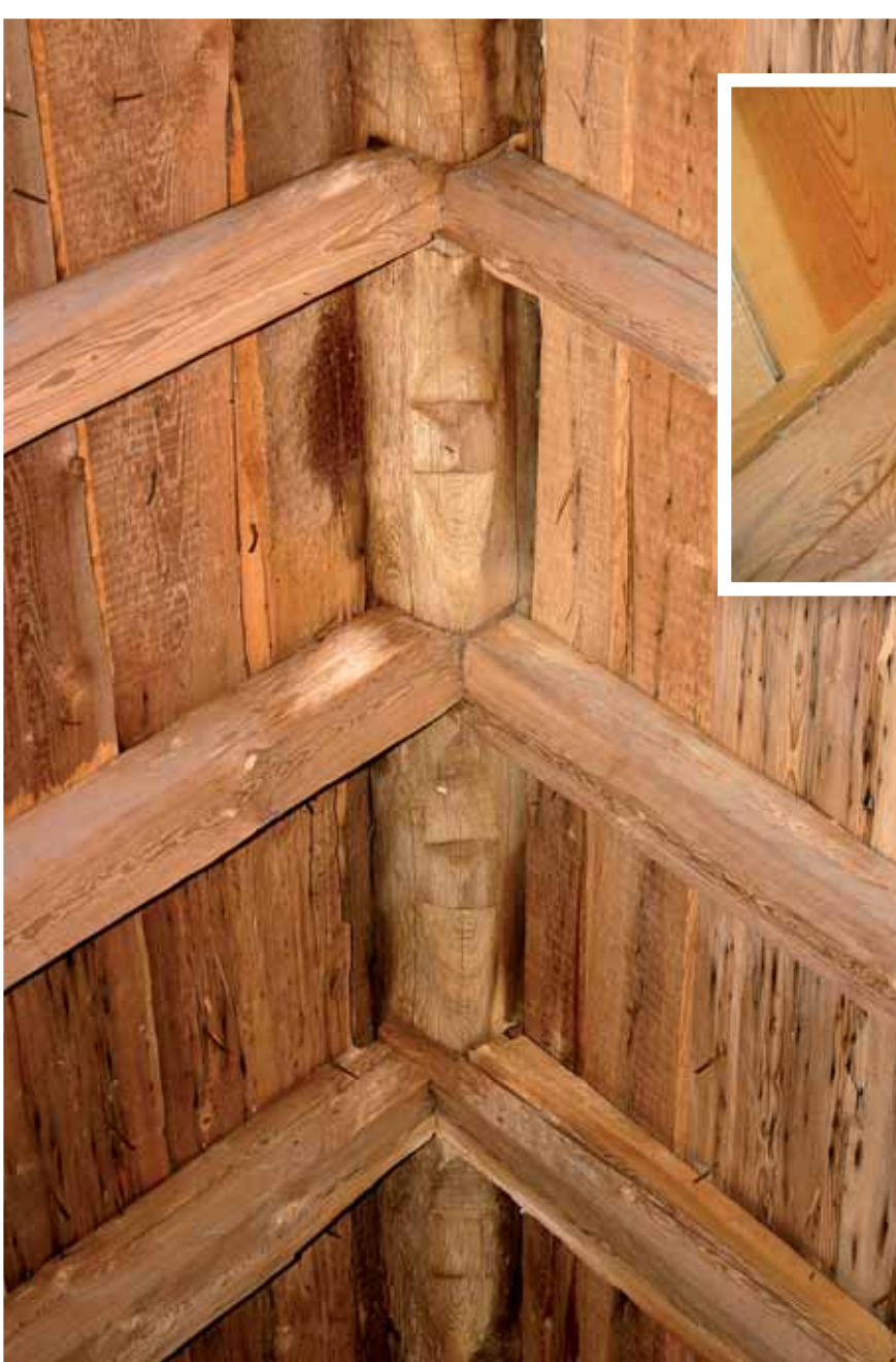
Exempel på taknocksförband och dekorerad nockås. Asby kyrka i Östergötland.
