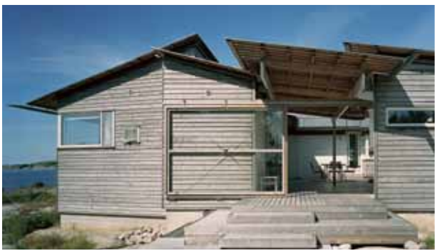
Till skillnad mot en helt obehandlad träyta ger järnvitriolen ett jämnare färgintryck.
