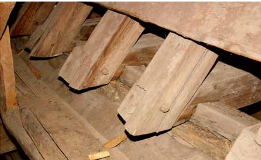
Exempel på verkliga takfotsförband. Dessa är från Asby kyrka i Östergötland
