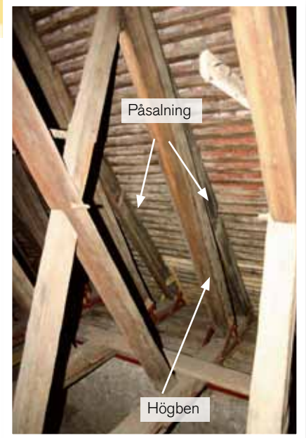
Exempel på påsalning av högben i en stor takkonstruktion. Kyrkan i Bistrita, Rumänien.
