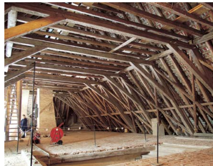
Takkonstruktionen från 1600-talet på Skoklosters slott i Uppland.
