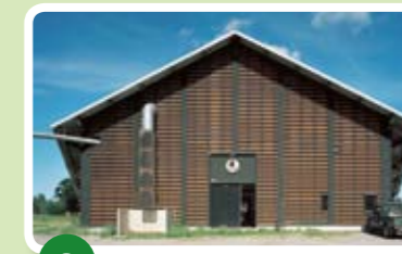
8 LÖHAMMAR LADUGÅRD, ÖSTHAMMAR
