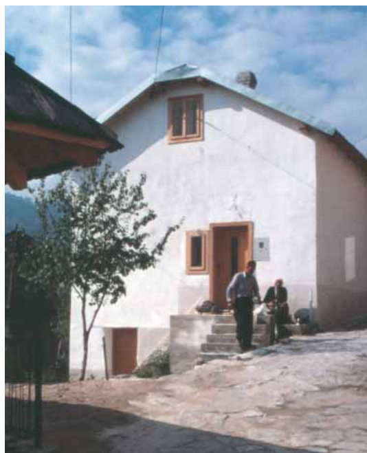
Detta återuppbyggda hus kallade vi Nanos hus, efter namnet på husägaren. Det hade en modernare takutformning och var ombyggt på 40-talet. Jajcehusen är korsvirkeshus där fyllningen traditionellt sett var av sten, men av kostnadsskäl var vi tvungna att byta ut stenen mot håltegel.
