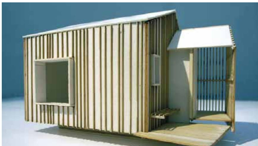
Modell av Ateljé, ur avgångsprojekt 2007. Genom att använda brädor i skiftande bredd som täcks av locklistor, skapas ett varierande skuggspel i fasaderna. Av Anna Englov.
