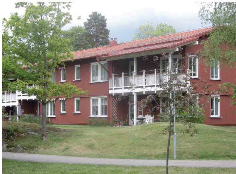
Husen i Wälludden har en träregelstomme där mellanbjälklaget av trä utfördes i en av de mellanbjälklagstyper som testades i flervåningshusen.
