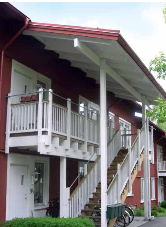
Husen i Wälludden har en träregelstomme där mellanbjälklaget av trä utfördes i en av de mellanbjälklagstyper som testades i flervåningshusen.
