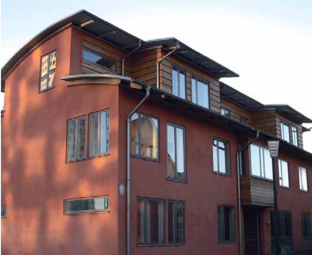
Kvarteret Hytten i Bo-01, Malmö, har en gles stålstomme som samverkar med massivträskivor. Alla väggar, även ickebärande mellanväggar, är av massivträ. Tredje våningen på gårdshuset har en oljad ekfasad.
