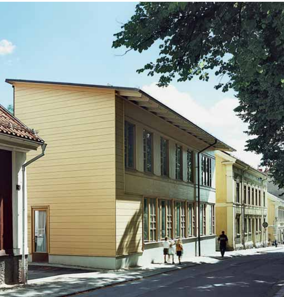
Nora Församlingshem är en träbyggnad med reglade väggar och en massiv träplatta i entrésolbjälklaget. Finrummet, intill caféet, har kontakt med både staden och övriga publika rum i byggnaden genom fönstren mot gata och entrégård.
