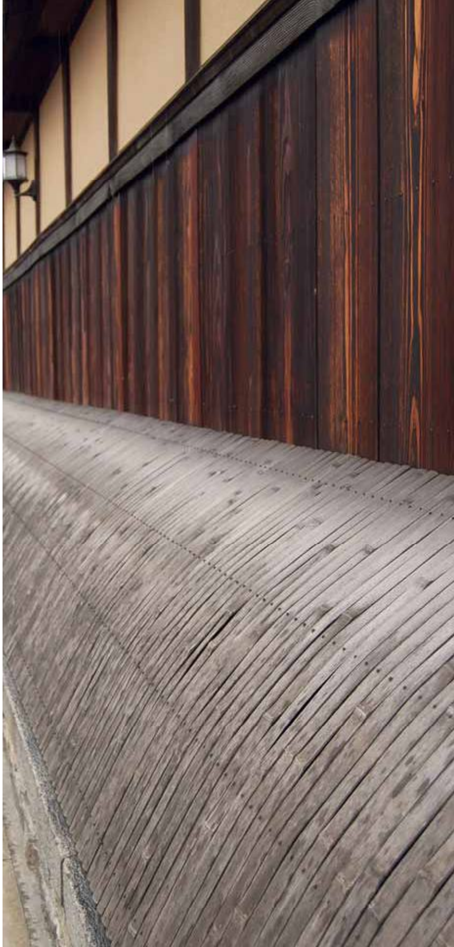
Bambukonstruktion som skyddar fasaden mot regn, Kyoto.
