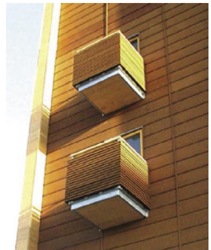
Träbalkong på balkongplatta av massivträ på ett flervåningshus i Sundsvall.
