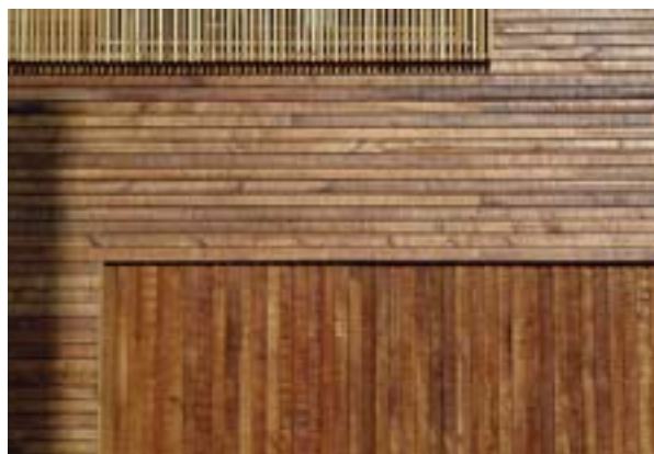
Fasaddetalj från Folkhem Produktions byggnad.
