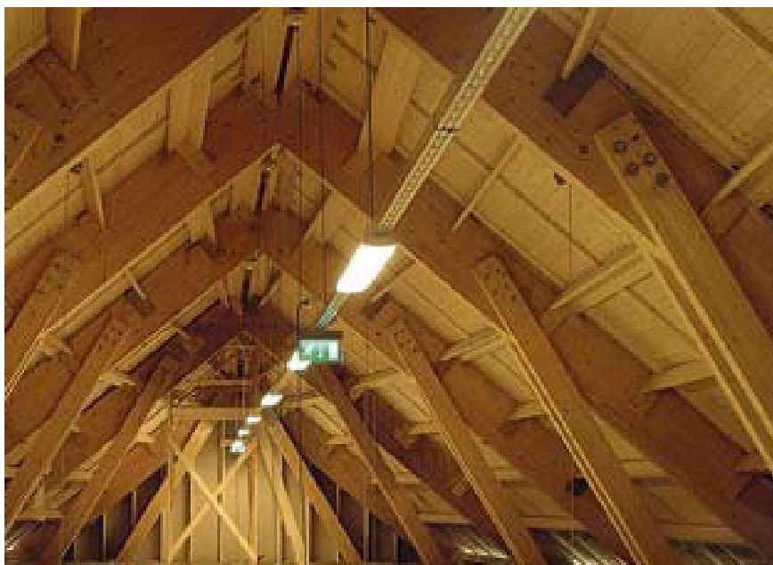
Kyrkovinden med limträstommen. De grövsta balkarna har dimensionen 630 x 165 mm.
