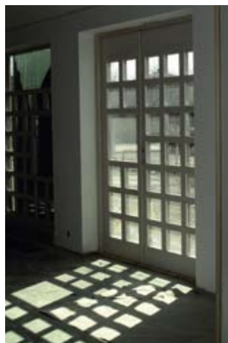
Fönster-/dörrpartier mot söder. Listverken är i obehandlad ceder som ska svartna med åren.
