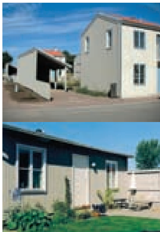
Fasaderna är putsade mot gatan med en ofärgad kalkputs. Övriga fasader är av spontad, stående slamfärgsmålade träpanel. Nedre bilden visar annexet.
