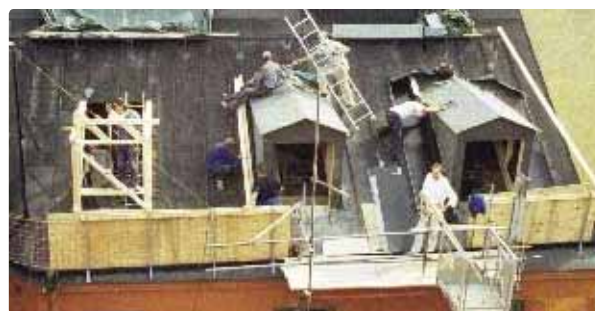
Här inreds vinden till en etagelägenhet och får nya kupor.
