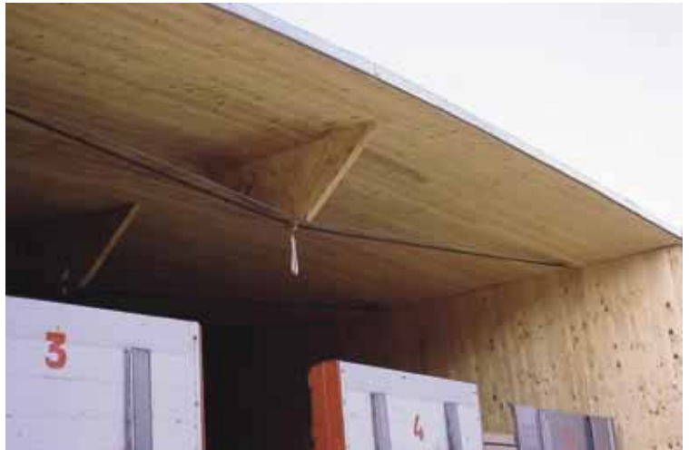
Underspänd takkonstruktion med massivträskiva. KLH fabrik Katsch an der Mur, Österrike.
