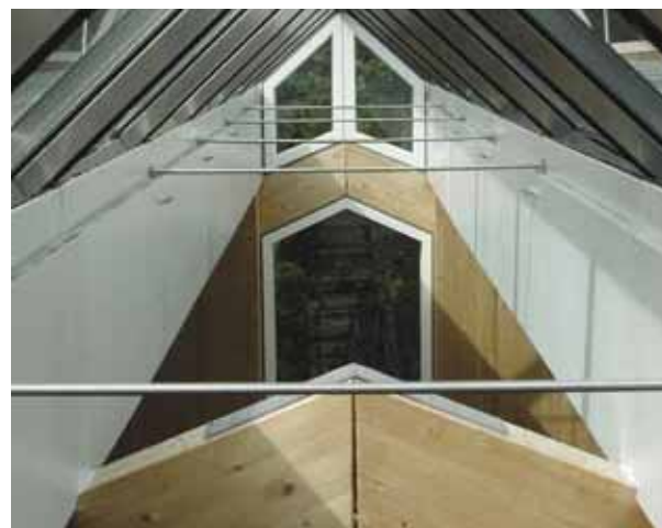
Den genomgående lanterninen ger ett ljusinsläpp i hela byggnaden.
