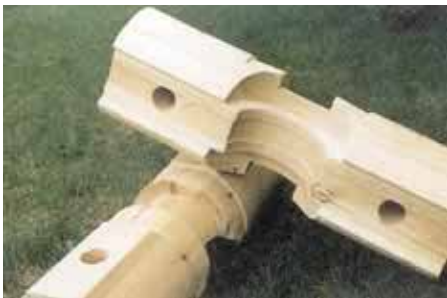
Traditionell hantverksmässig timmerteknik med bilade koniska stockar.
