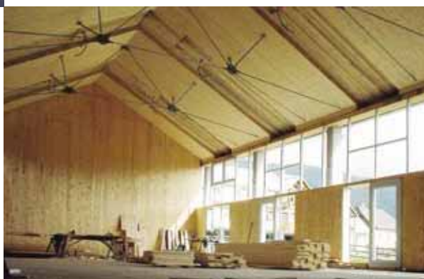
Gymnastiksal under byggande, Krakaudorf, Österrike.
