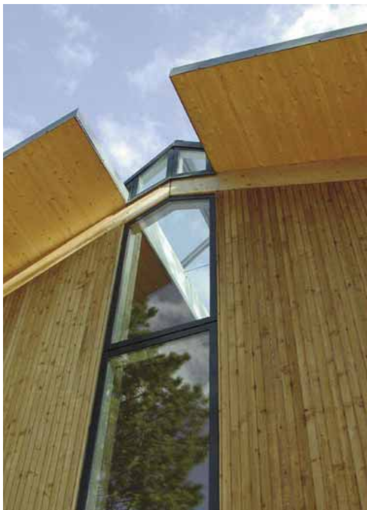
Massivträelementen i taket kragar ut och bildar ett arkitektoniskt snyggt överhäng.
