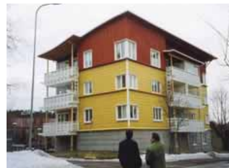
Sprinkler medger användning av träfasader. Exempel från Lahtis i Finland.
