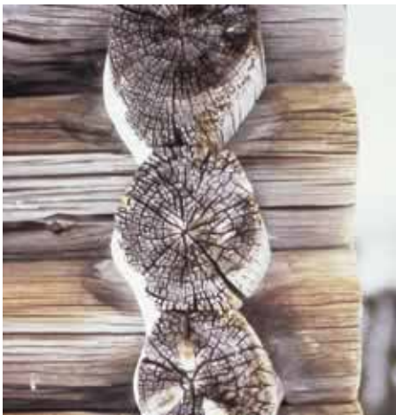
Traditionell hantverksmässig timmerteknik med bilade koniska stockar.
