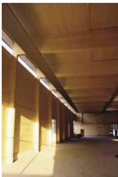
Bryggerilokal med vägg- och takskivor av massivträ, Murau, Österrike.
