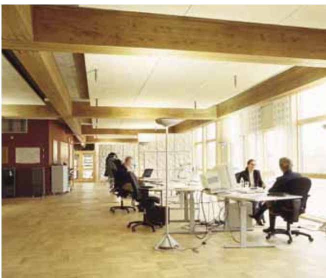
Massivträtekniken är synlig i interiören.
