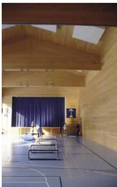
Gymnastiksal i skola i S: t Peter, Schweiz. Massiva väggar. Även takstolen är en mekaniskt sammansatt massivträkonstruktion med inbyggt dragband i underkant.
