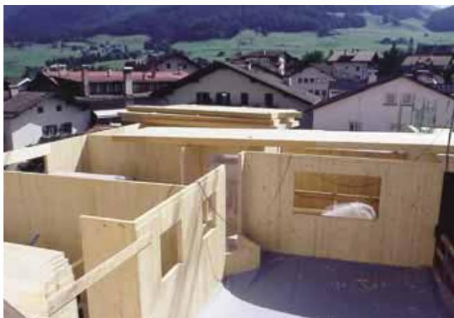
Massiva bjälklag och väggar i hotellbygge, Kastelruth, Italien.
