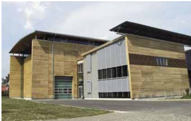
Underspänd takkonstruktion med 22,5 m fri spännvidd samt ytterväggar av massivträ. Byggtekniskt laboratorium, Technische Universität, Graz, Österrike.
