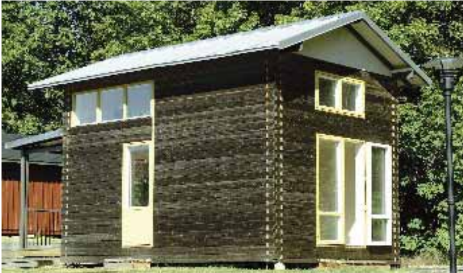
Mot söder har den vitriolbehandlade väggen antagit en nästan svart färgton. Fönsterbanden och rumshöjden ger interiören ljus och rymd.
