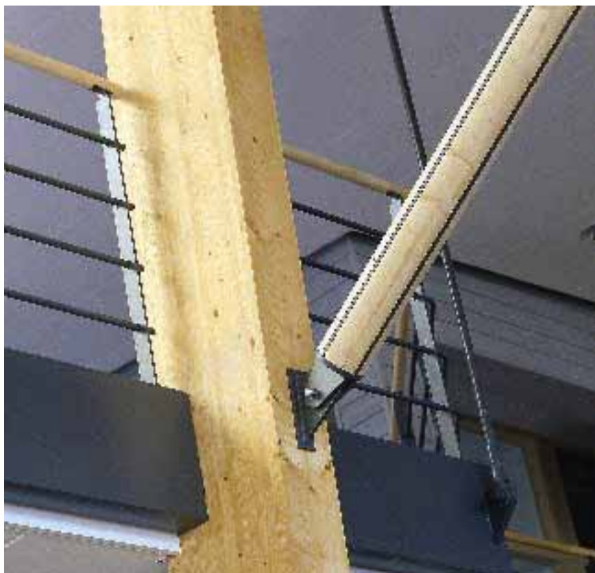
Limträbalk håller upp ramp på plan två.
