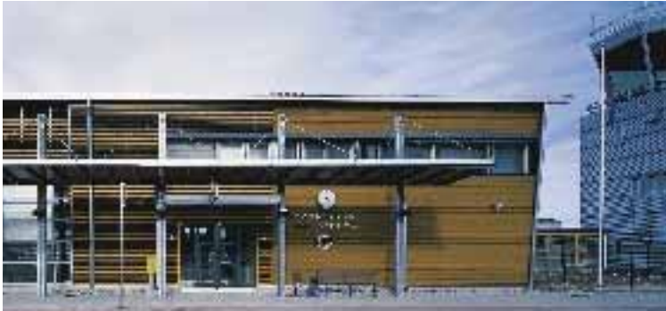
Ovan och t.h. entréfasad.
