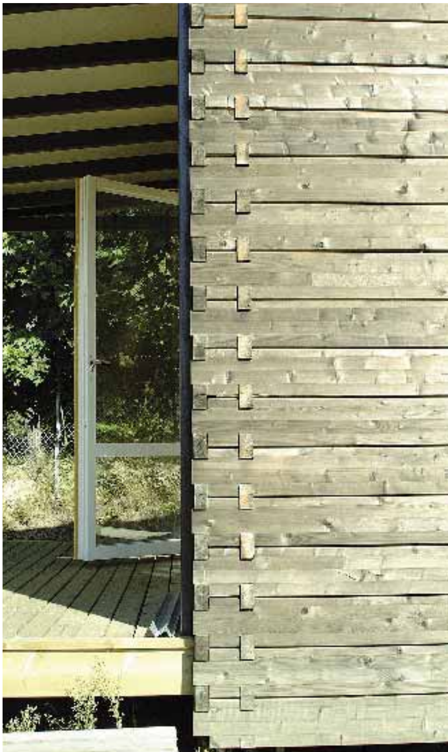
Knutarna, precisionen och väggens struktur ger byggnaden en distinkt karaktär.
