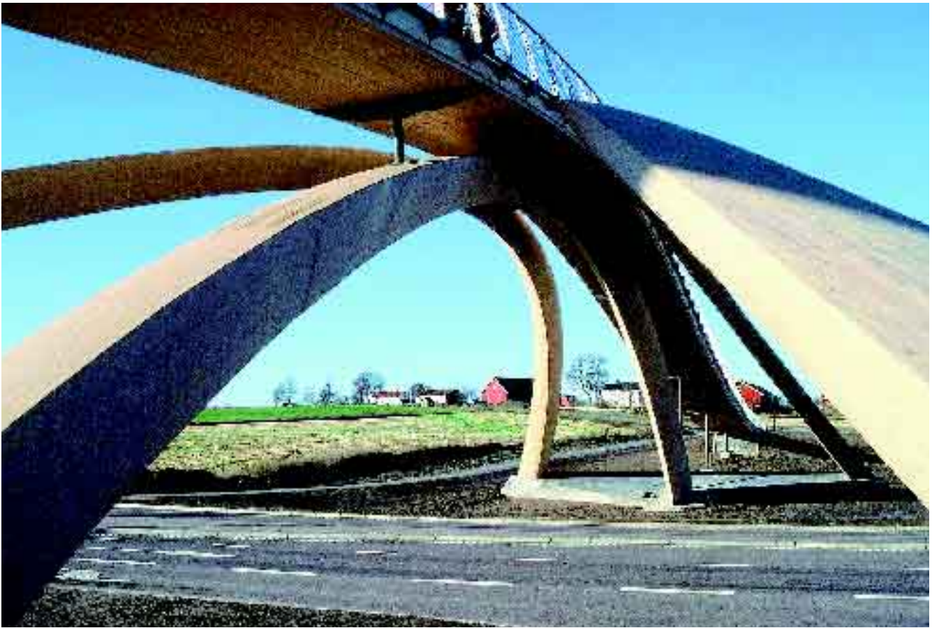
Bron vilar på tre limträbalkar varav den mittersta bär brodäcket.
