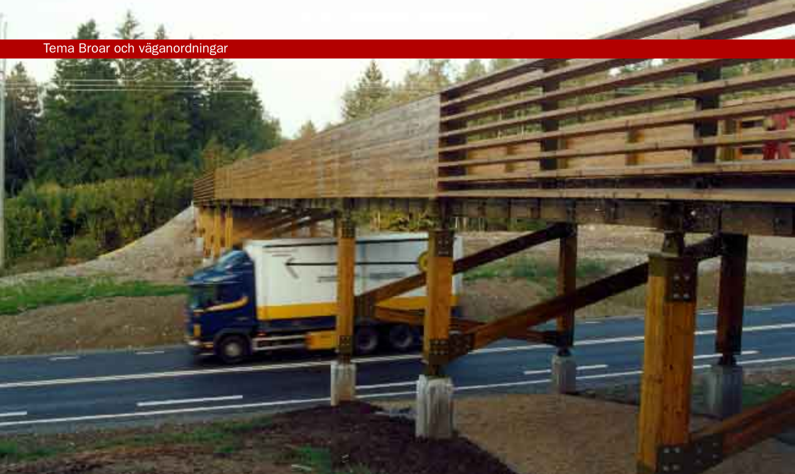
Balkbro Nynäshamn Beställare: Vägverket Längd: 62 m Bredd: 4,5 m Brotyp: Gång- och cykelbro Dimensionering: Bro 94 Foto: Per Bergkvist
