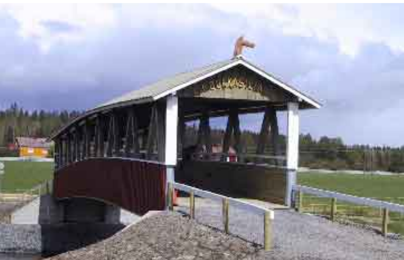
Hängverksbro Beston bron , Norge Beställare: Norska vägverket, Buskerud Längd: 24 m Byggår: 1999 Brotyp: Vägbro Dimensionering: Norsk brostandard Foto: Nordic Timber Bridges
