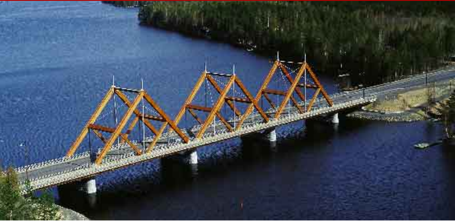
Fackverksbro Vihantasalmi , Finland Beställare: Finska vägverket Längd: 182 m Byggår: 1999 Bredd: 11,0 + 3,0 m Brotyp: Vägbro och gång- och cykelbro Foto: Nordic Timber Bridges
