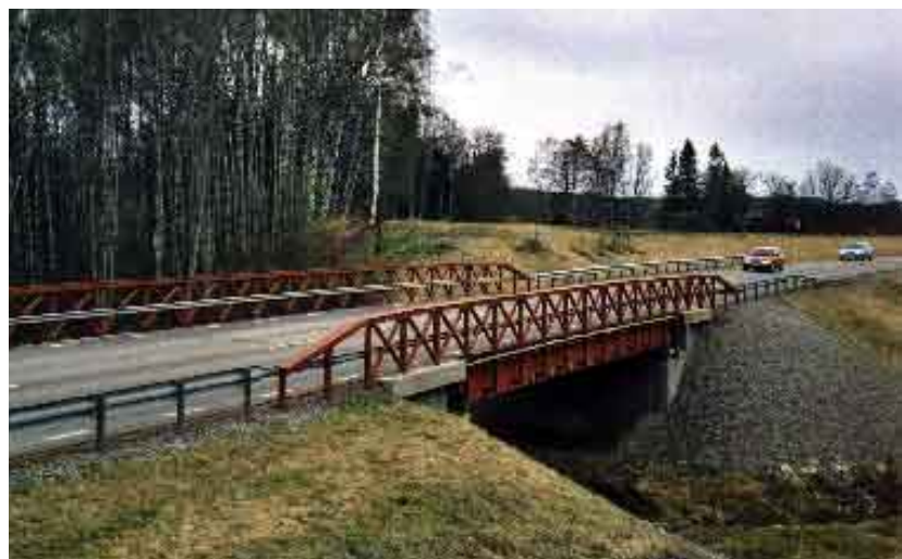
Snedstagsbro Spångerum Beställare: Linköping kommun Längd: 95,5 m Byggår: 2000 Bredd: 3,5 m Brotyp: Gång- och cykelbro Dimensionering: Bro 94 Foto: Svenska Träbroar
