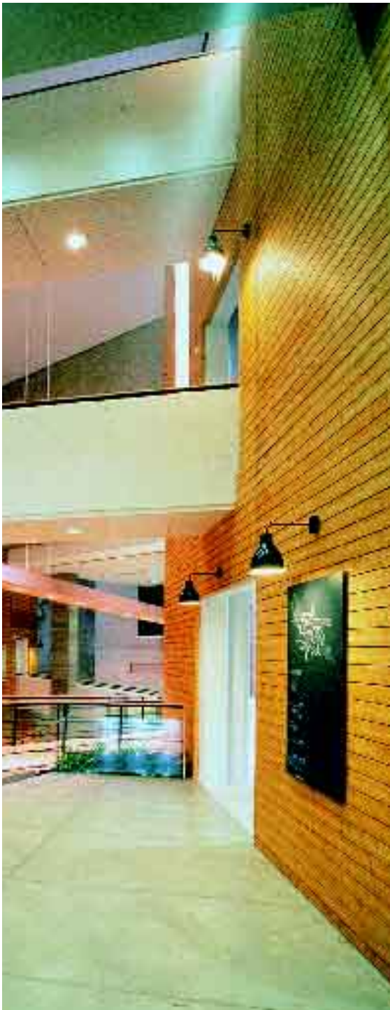
Träpaneler i kombination med betongväggar.
