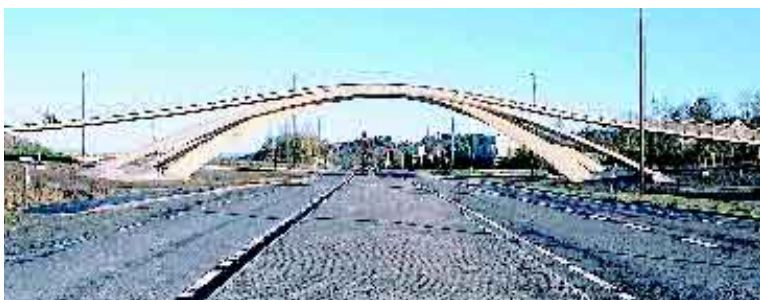
Leonardobron är totalt 110 meter och huvudbalken ligger som mest nio meter ovanför den fyrfiliga motorvägen.
