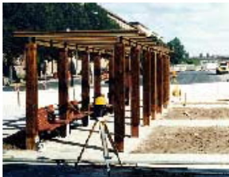
Järnvägsparken på Västerås Central. Räls ovan slipers.
