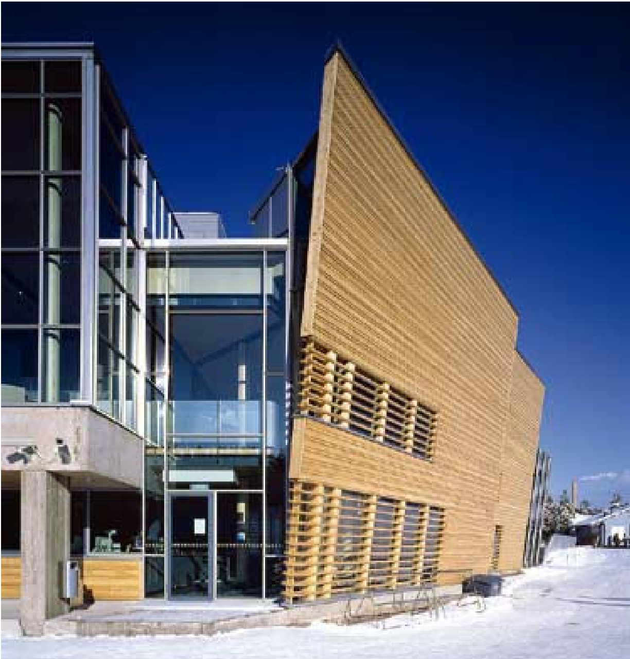
Entré i bottenvåningen.
