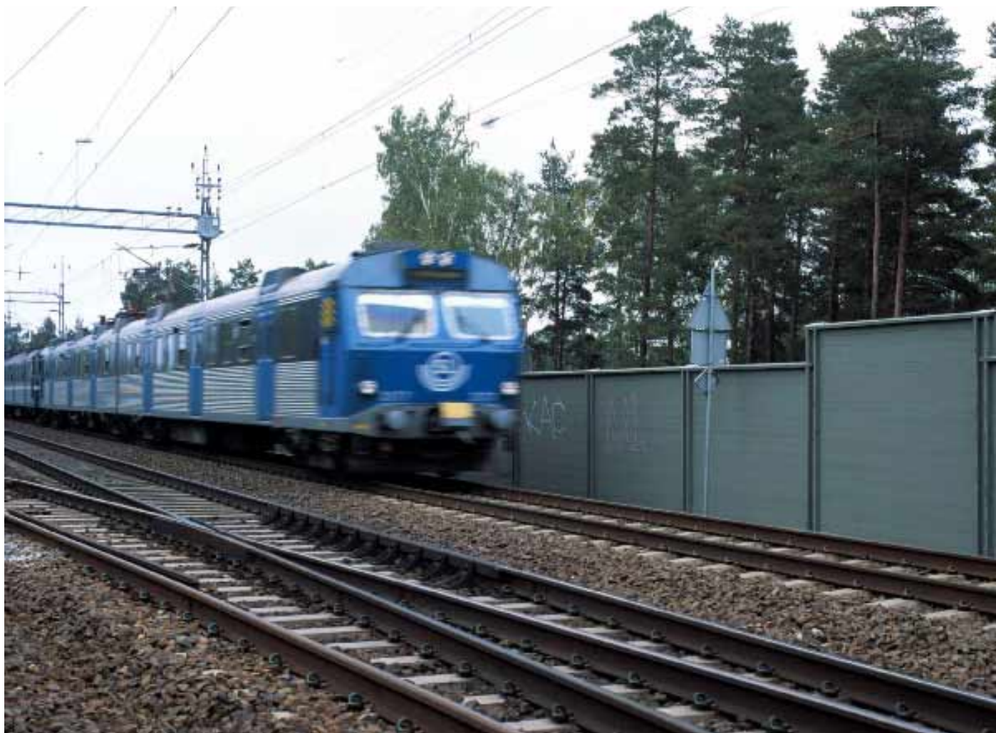
Bullerskärm strax söder om Jordbro station utanför Stockholm. Skärmen är byggd av Litto-systemet och är 300 meter lång och 3 meter hög. Ljudreduktionen är 26 dB vilket ligger inom klass B3.
