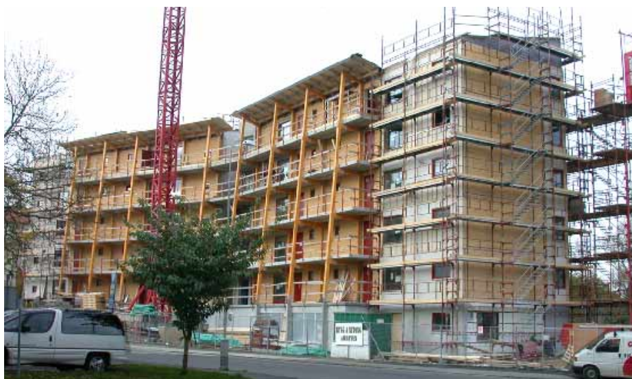
Två huskroppar sammanbundna av loftgången i trä.
