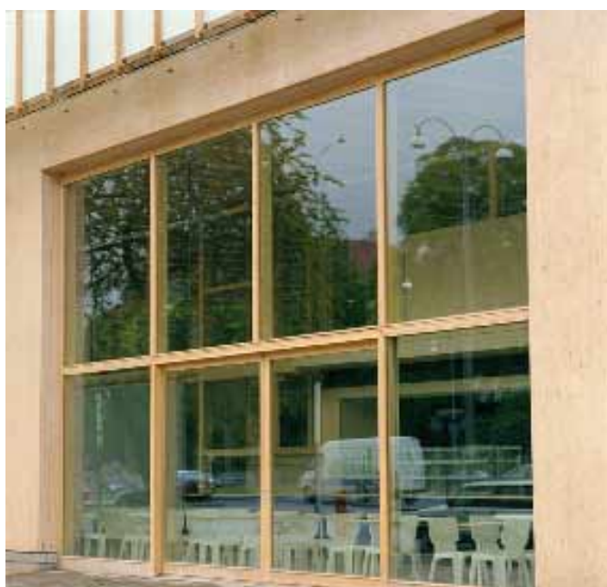
Nedre våningen ut mot Södra vägen. Pelare 500x1 200 och bärlina 500x1 000.
