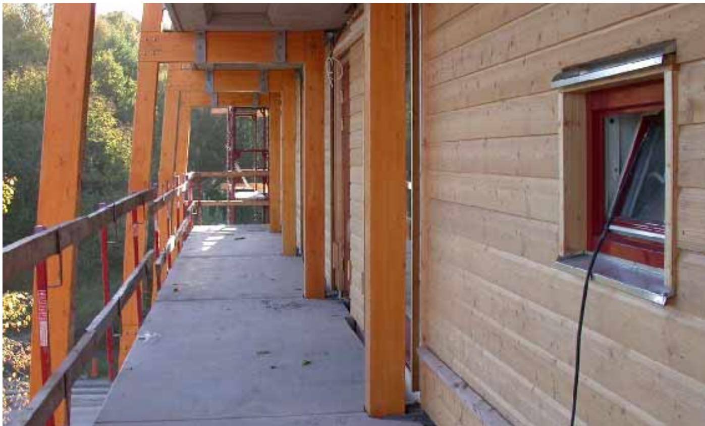
Den södervända träkonstruktionen.
