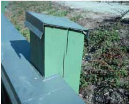
Stolpens topp är täckt med ett plåtbeslag.
