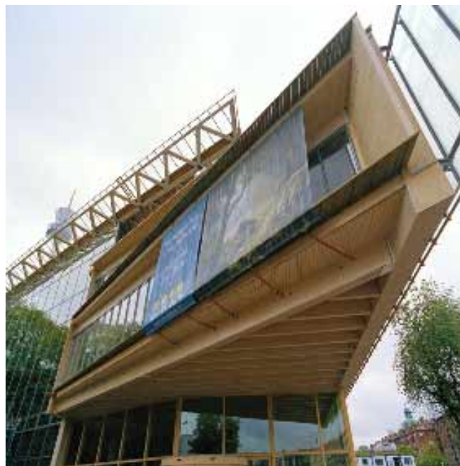
Entrésidan har ett stort överhäng, cirka 15 meter.
