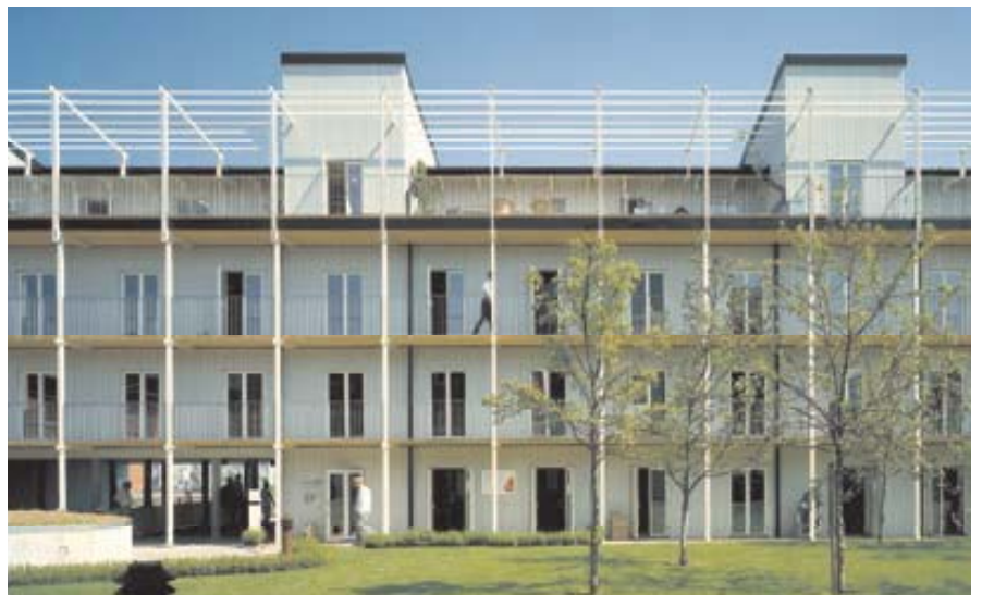
Kvarterets innergård med vy över kanalhuset.
