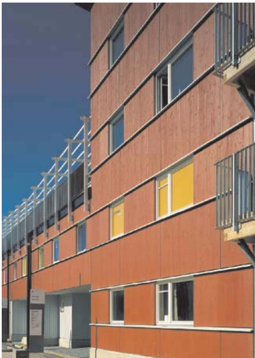
Trähusets västra fasad ut mot gatan.
