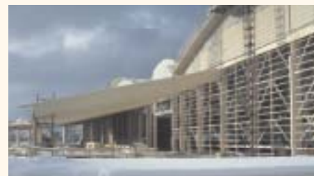
Ovan Montage av fackverksbåge.
