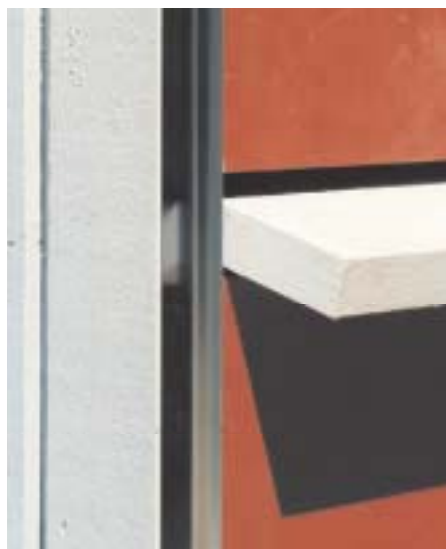
Från vänster ses Kaunapanel, expanderlist för den röda treskiktsskivan och vit droplista av kaunabehandlat kärnvirke.
