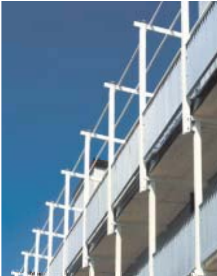
Massiva limmade träelement i balkongerna på Trähuset.
