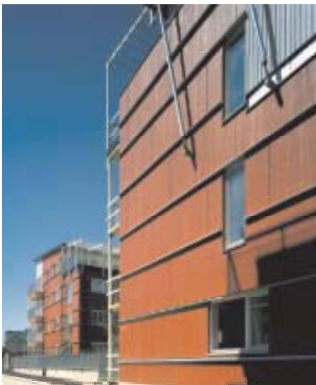
Vy från kanalen upp mot punkthuset.
