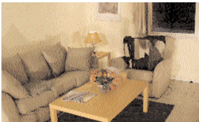
... och med boendesprinkler.
