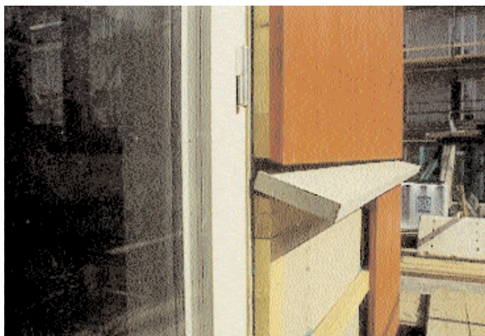
I den röda fasaden används den nya treskiktsskivan. Fönsterbrädan är av kärnfuru.
