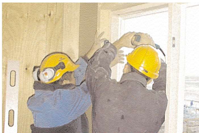
De kvalitetssäkrade Kaunafönstren med utvald kärnved monteras i Trähus 2001.
