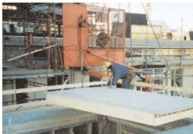
Bjälklaget SödraSemi används i Trähus 2001. Här läggs det på plats.
