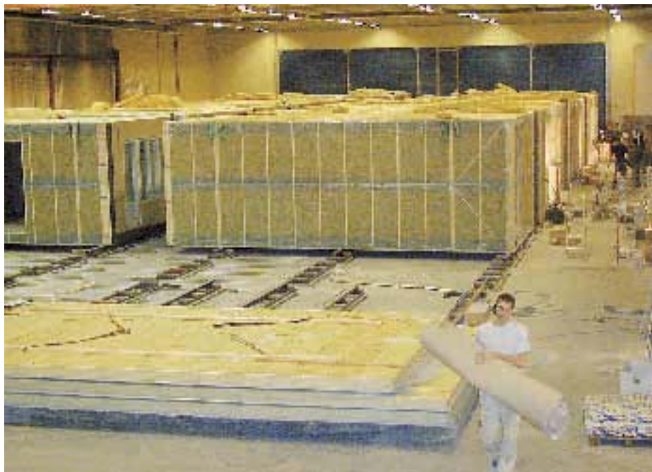
Prefabricerade volymelement för utlastning.
