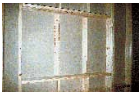
Inifrån syns förberedelsen för en fönsteröppning.
