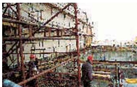
Inga fönsteröppningar under byggtiden ger vädersäkert byggande.
