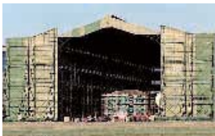
Zeppelinhangarens storlek är imponerande och får sexvåningshuset att likna ett dockhus.
