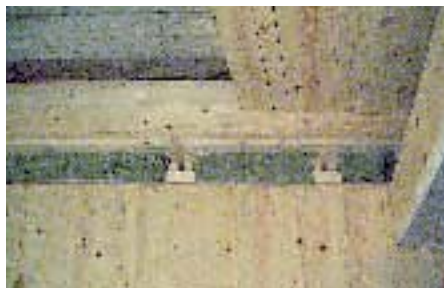
Ljudspärrar av trä placerade mellan bjälklag och upplag.
