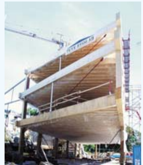
I augusti såg det ut så här på byggarbetsplatsen.
