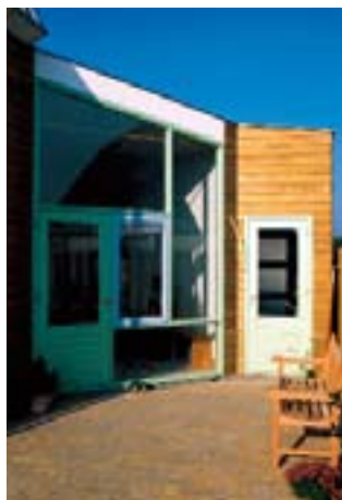
Gemensam entré med hög hall, på norra sidan.
