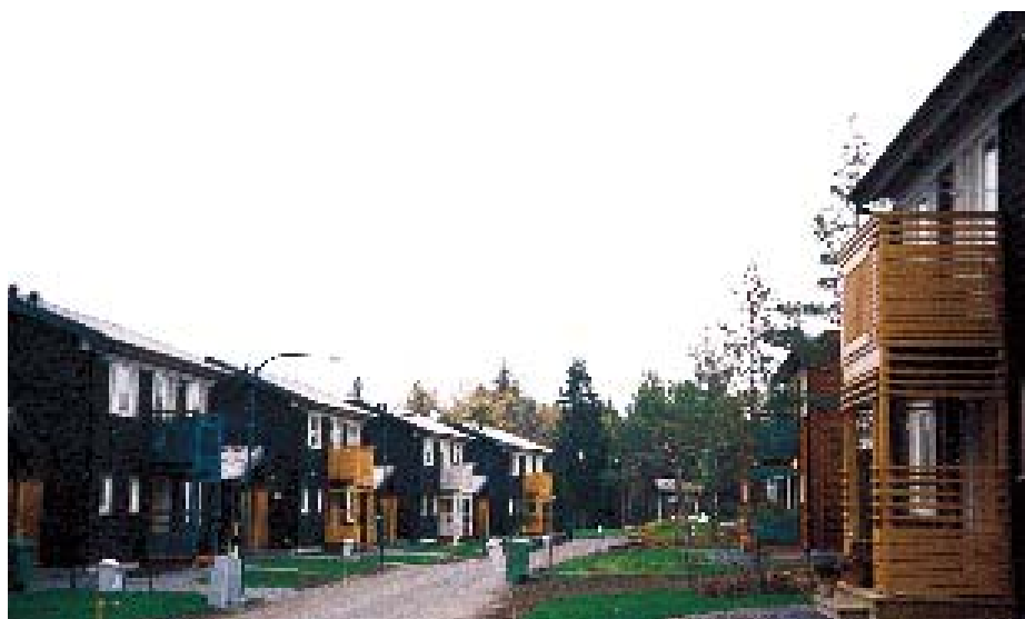
Husen med långsida mot gatan.
