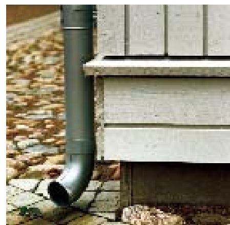
Sockeldetalj med liggande panel och vattbräda.
