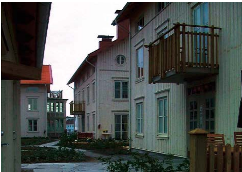
Den traditionella staden innehåller ofta små variationer inom ett givet tema, där material, hushöjder och uttryck skapar en identitet. Förtätning med grupphus är ofta ett bra komplement inom en bevarad helhet. Bild och situationsplan från Marstrand, där arkitekt SAR Kjell Forshed strävat efter en arkitektur som överlever tiden, inte speglar den och snabbt blir omodern.
