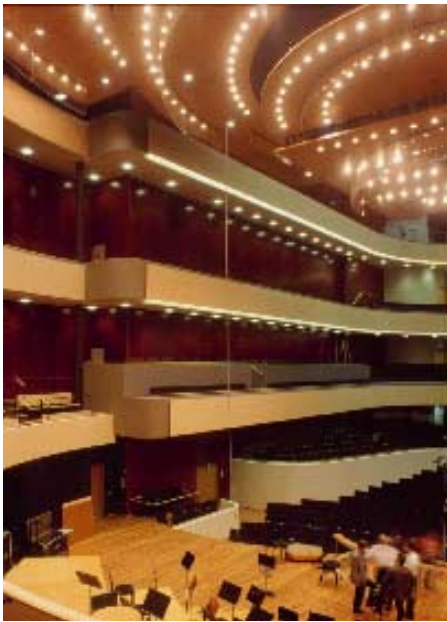
Balkongerna inne i konserthallen är uppbyggda av limträ och kertobalkar. På ytan har de klätts med björkfaner.
