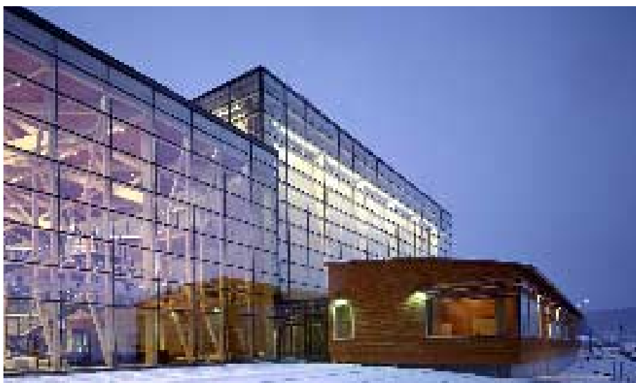
Genom glasfasaden mot sjön Vesijärvi ses både skogshallens spretande kolonner och delar av den avancerade ljudväggen. Det låga huset till höger innehåller kongresshall.
