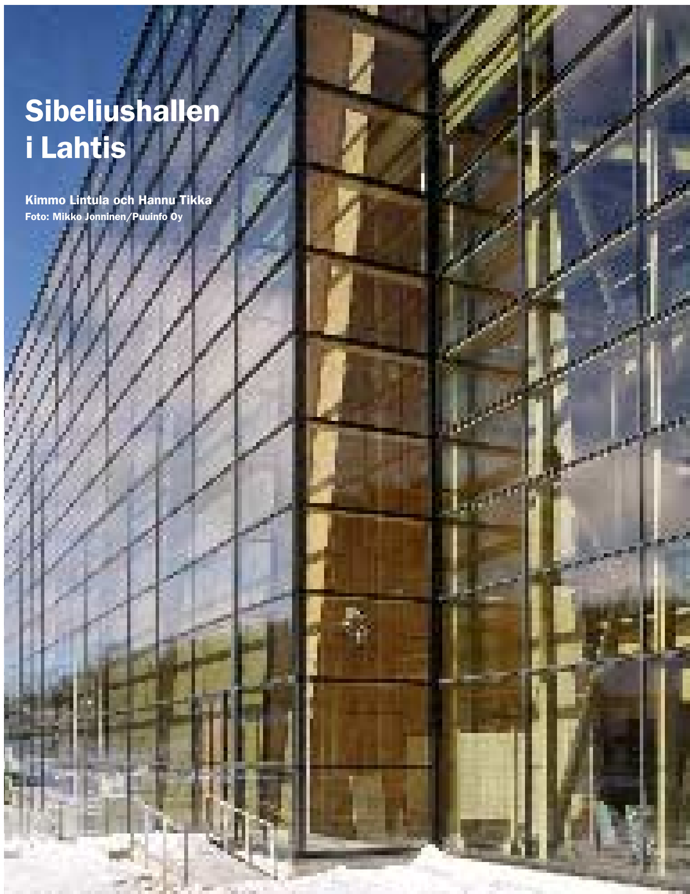
Glasfasaden på ingångssidan, den södra fasaden, av konserthuset i Lahtis. Innanför syns ljudväggens limträkonstruktion.
