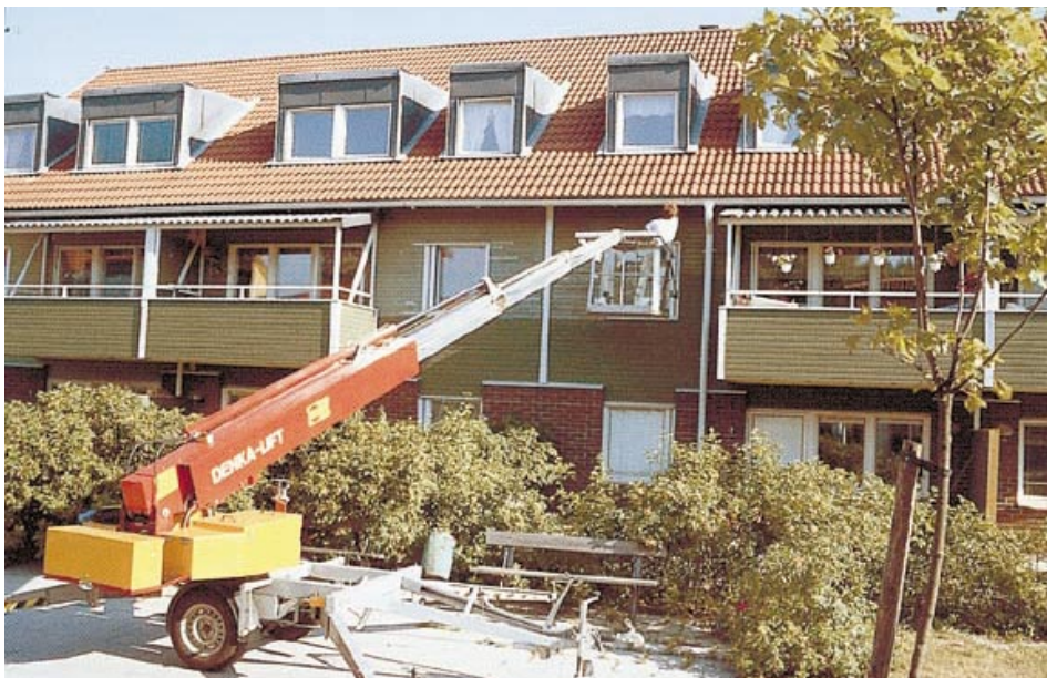
Med hjälp av en kran görs det utvändiga underhållet både lättare och snabbare.
