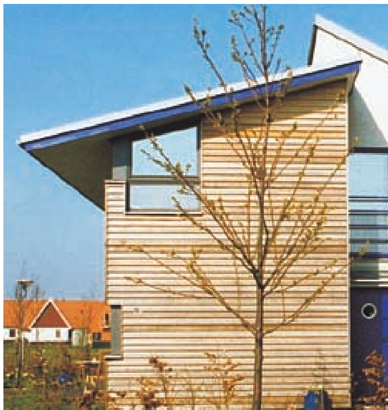
Fasad av Western Red Cedar. Efter två år kan man börja notera skiftningar i färg hos olika bräder. Bräderna upp under taksprången är de som sist kommer att färgförändras. Ljusets hus i Staffanstorps. Arkitekt Henrik Jais-Nielsen
