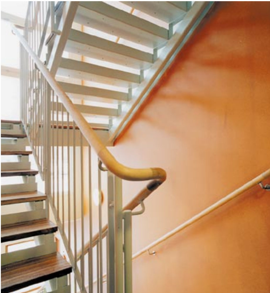
Trappsteg och vilplan är av trä och bärs av en stålkonstruktion. ➤
