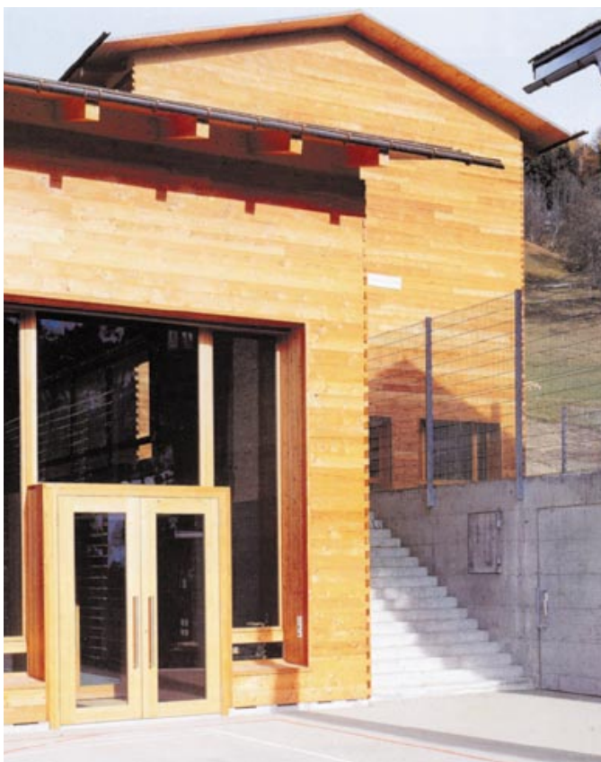
Skola i St Peter i Schweiz, arkitekt Conradin Clavout, konstruktör Jürg Conzett, 1994-98. Skolan är byggd i en massivträkonstruktion. De stora öppningarna i fasaden kräver särskilt konstruktiva lösningar för att klara rörelser i träet. Konstruktionen är i furu och gran. Fasad av lärk.
