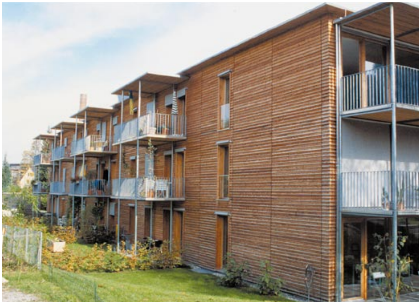
Flerbostadshus i Dornbirn i Österrike, arkitekt Hermann Kaufmann, 1997. Detta är ett pilotprojekt avsett att studera lågenergilösningar kombinerat med flervåningshus av prefabricerade träelement. Fasad av obehandlad lärk. Fönstersnickeri av Oregon Pine.
