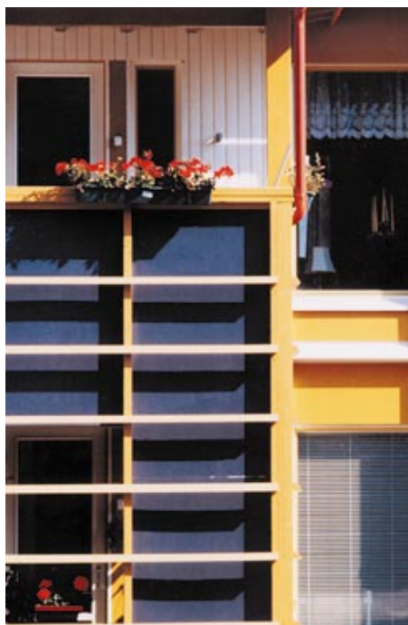
Större delen av fasaderna utgörs av trä vilket är möjligt genom att husen är sprinklade.
