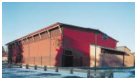
Trä och tegel har kombinerats för att gymnasikhallen ska smälta in i Tyresös kulturmiljö och med Strandskolan till vilken hallen hör.
