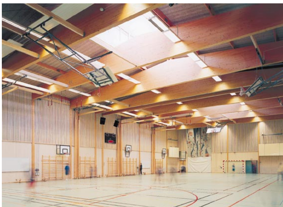
Tyresöhallens tak bärs av sadelbalkar av limträ och bärande träullsplattor. Takhöjden är 7,5 m och spännvidden 23,7 m. Balkens bredd är 215 m, höjd 742-1 935 m och total längd 23,9 meter.
