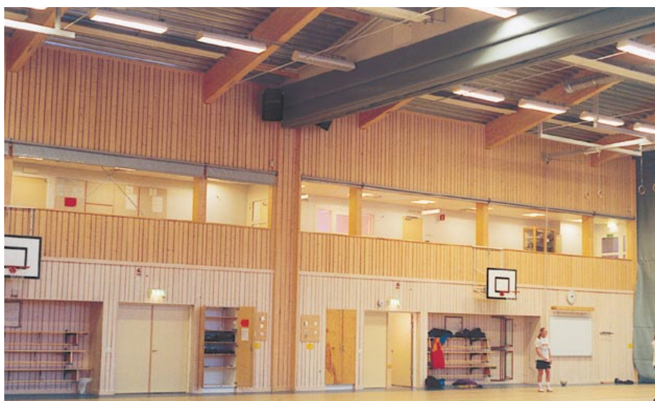
Takkonstruktionen är uppbyggd av treledsramar i limträ, med dragstag, som syns tydligt upp mot innertaket.
